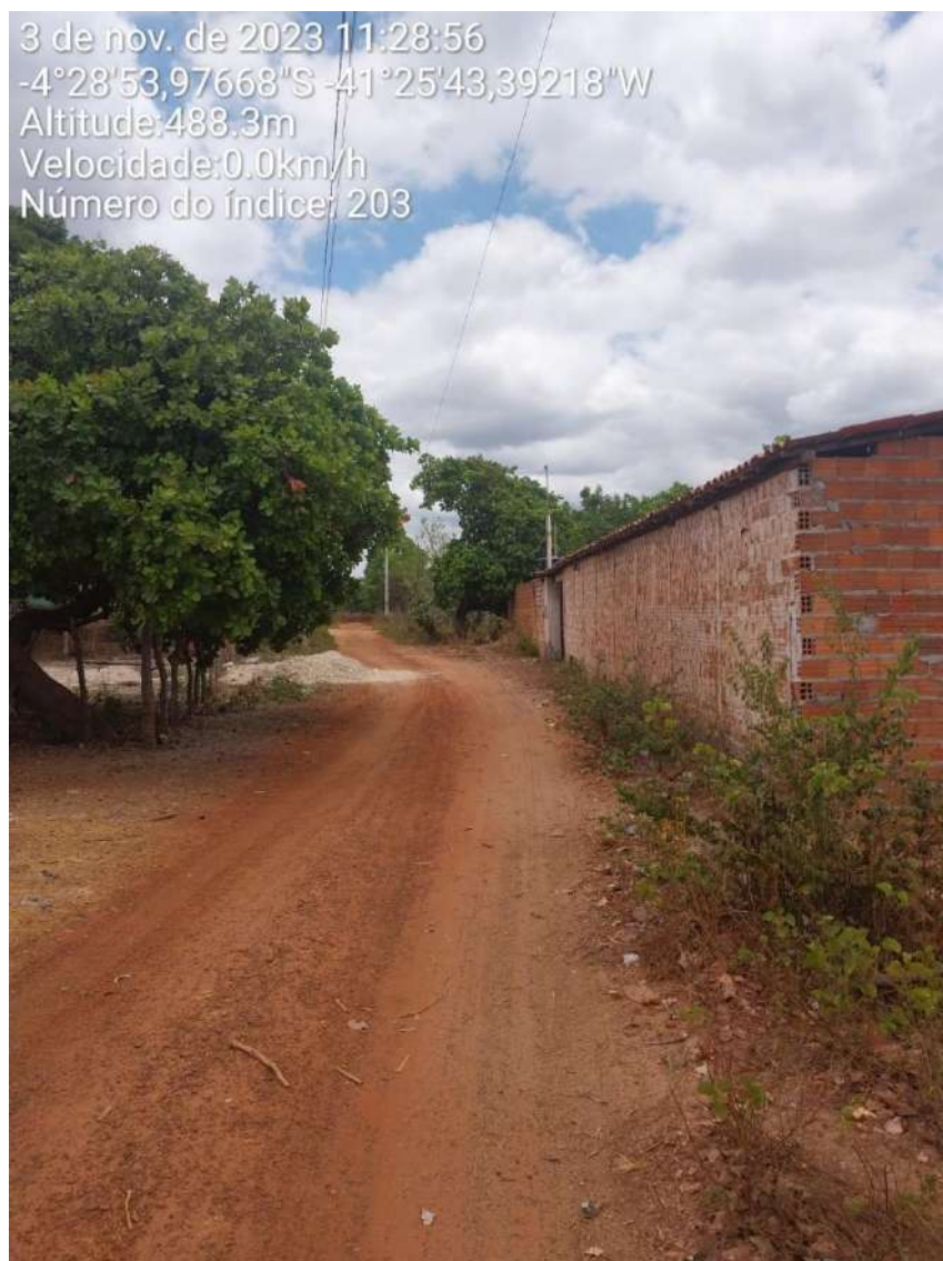
Imagem 03– Visão do final do trecho
