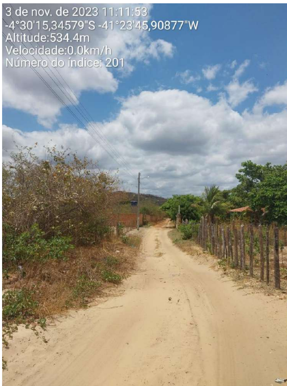
Imagem 03 – Visão do final do trecho
