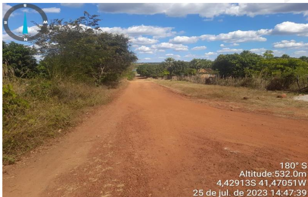
Imagem 02 – Visão do final do trecho
