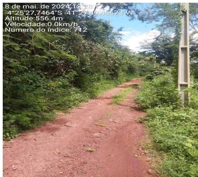
Imagem 02 – Visão do final do trecho
