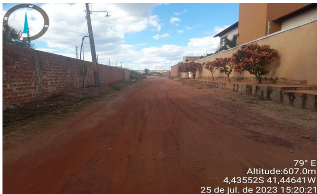
Imagem 02 – Visão do final do trecho
