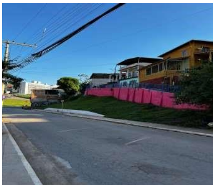
Figura 3 – Geometria do terreno Fonte: Autores, visita técnica maio/2024.
