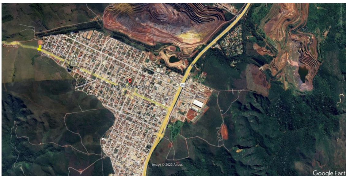
Figura – Localização da contenção M-05, no bairro Jardim Canadá. Fonte: Google Earth
