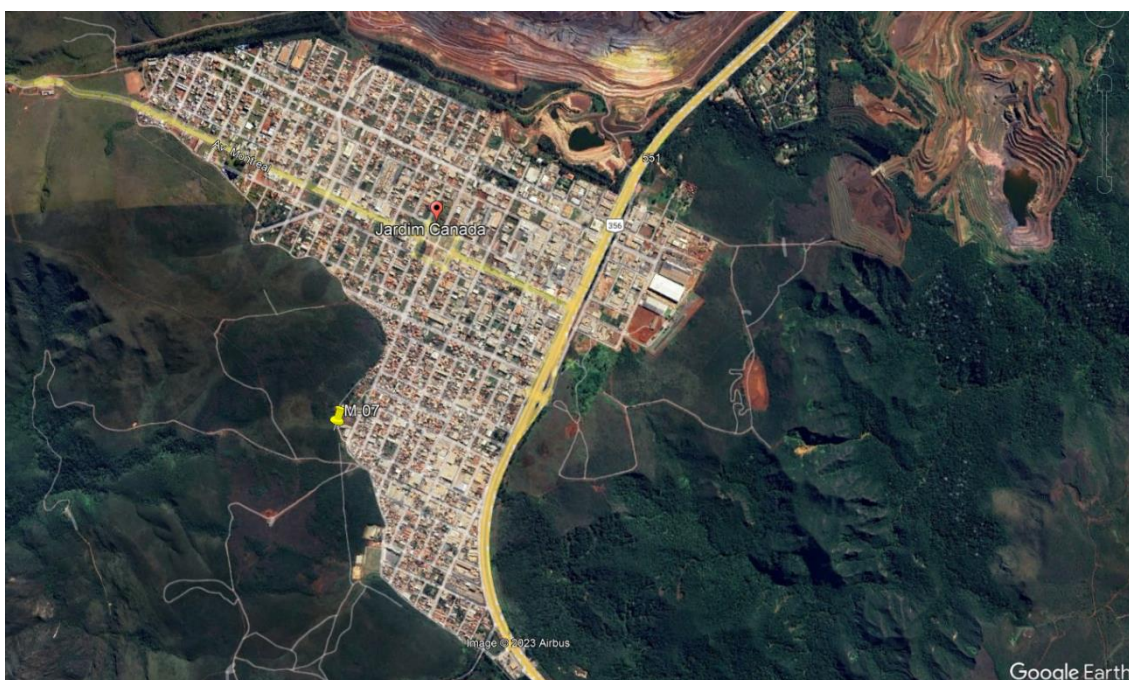
Figura –Localização da contenção M-07, no bairro Jardim Canadá. Fonte: Google Earth
