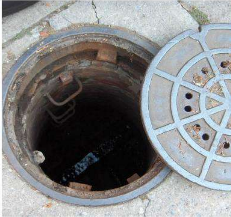
Figura 8 - Poço de visitas.
