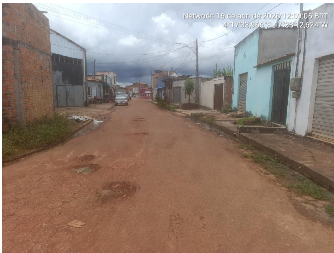
Foto 25: Início Rua Leopoldo Cunha – Trecho I.
