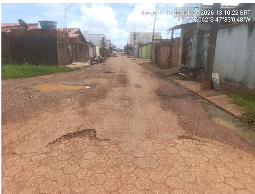
Foto 30: Final Rua Leopoldo Cunha – Trecho III.
