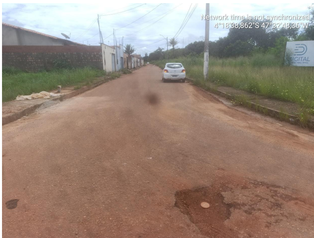
Foto 22: Final Rua Sete de Setembro – Trecho II.
