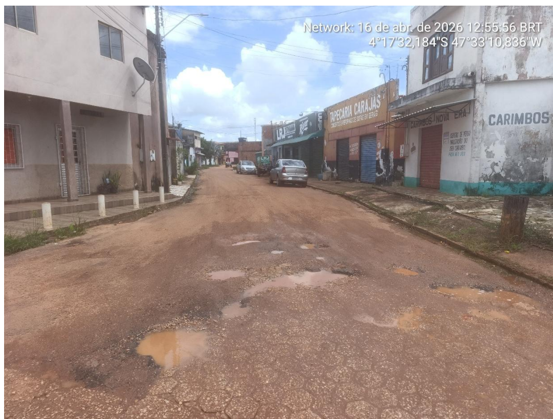
Foto 26: Final Rua Leopoldo Cunha – Trecho I.
