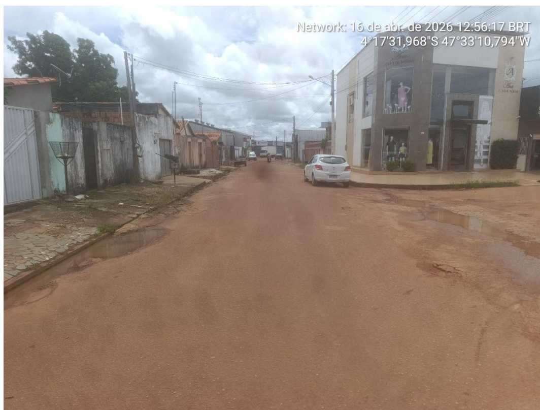
Foto 35: Final Rua Barbosa – Trecho I.
