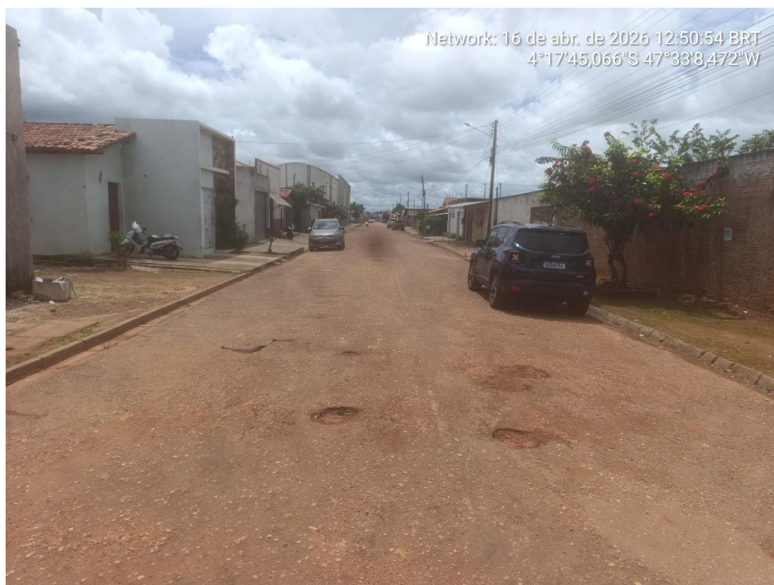
Foto 39: Final Rua Barbosa – Trecho III.
