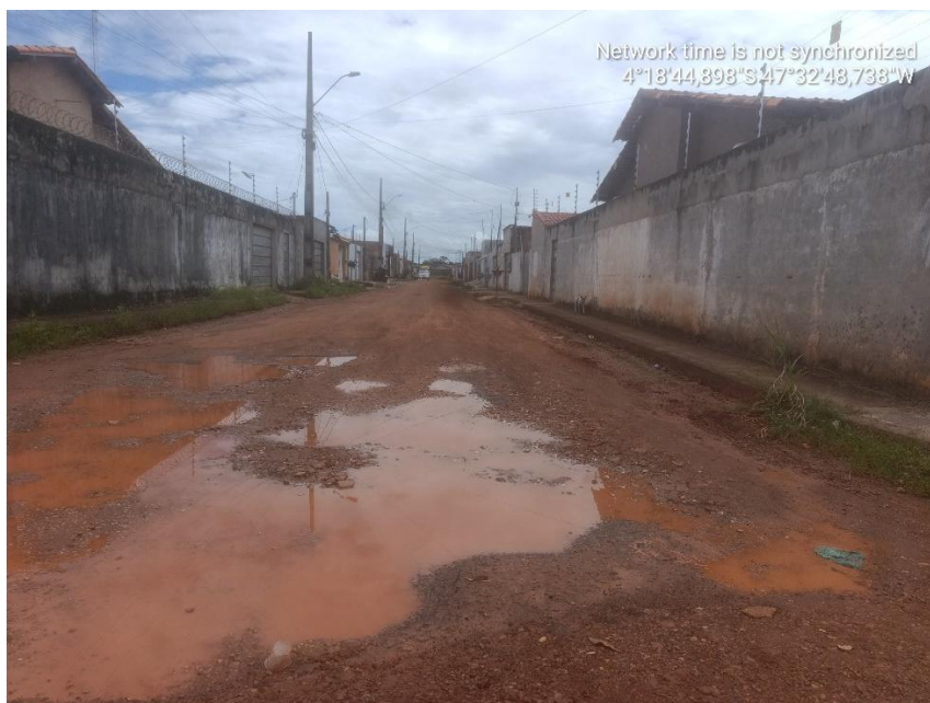
Foto 48: Rua João Paulo II Trecho II.
