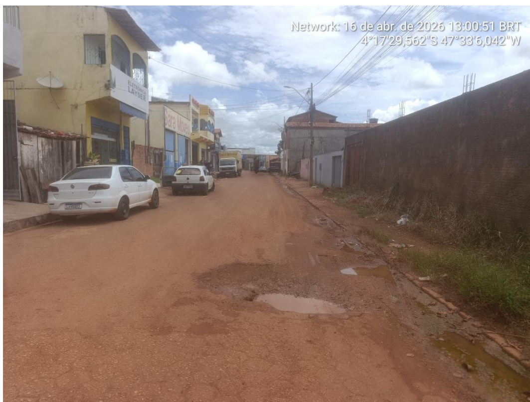
Foto 28: Final Rua Leopoldo Cunha – Trecho II.
