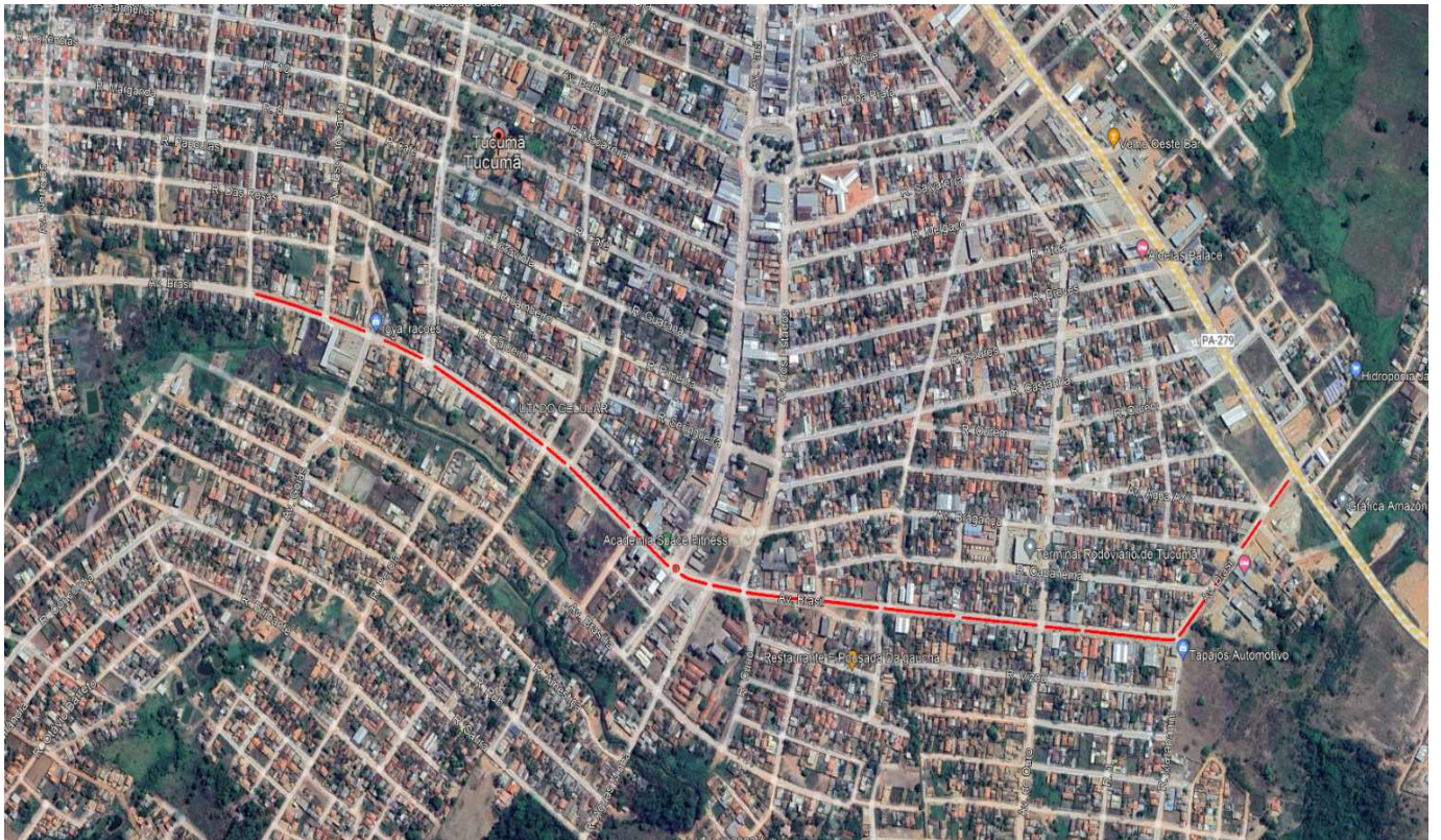
Figura 1 - Local de Atendimento da Iluminação Pública
