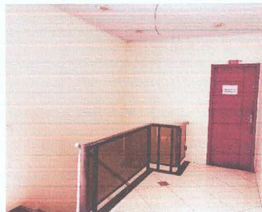
Imagem 6: Hall, acesso as salas do piso superior.
