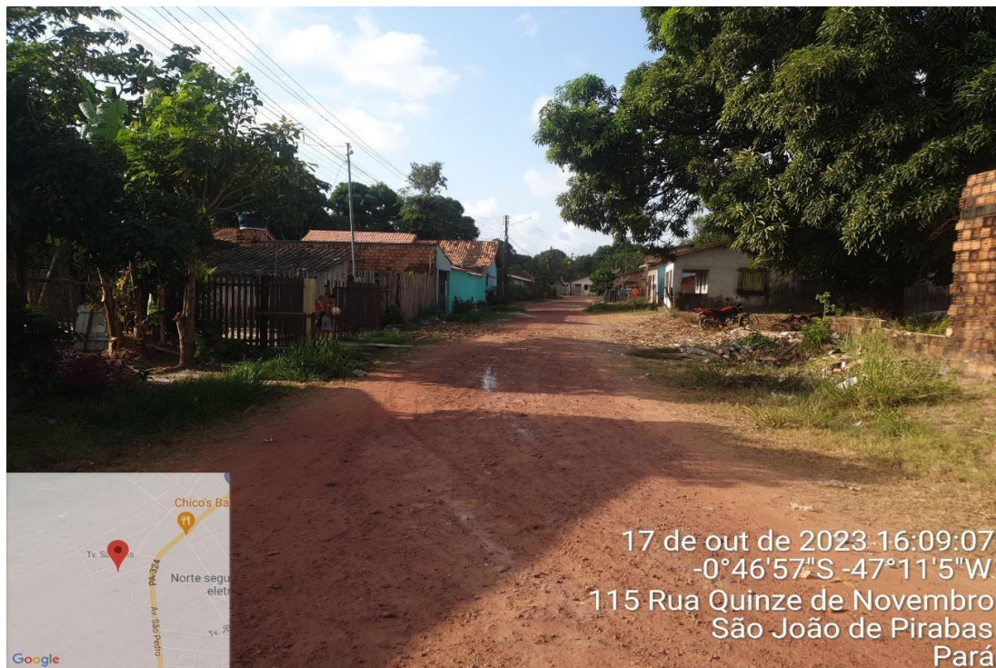
FOTO 12- RUA 15 DE NOVOEMBRO- Final da via
