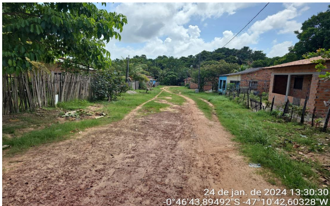
FOTO 18 – TRAV. SÃO SEBASTIÃO – Final da Via
