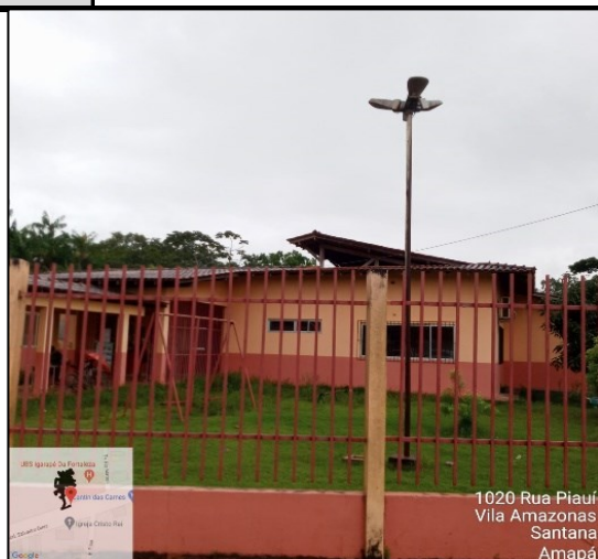
FACHADA DA EDIFICAÇÃO.
