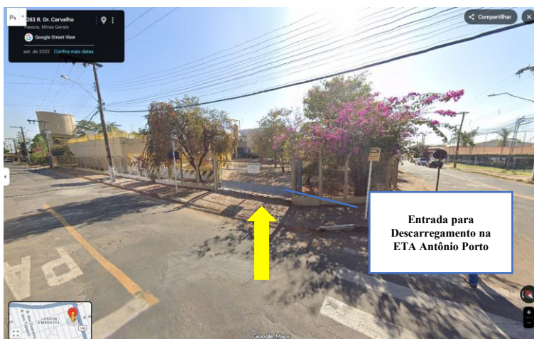
Figura 3 - Entrada para a área de descarregamento do sal grosso na ETA Antônio Porto.
