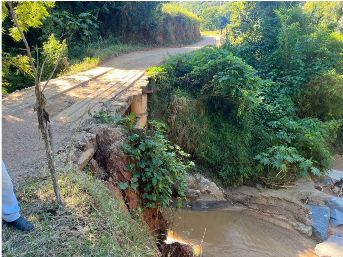
Foto 3: Local de implantação do bueiro ARMCO
