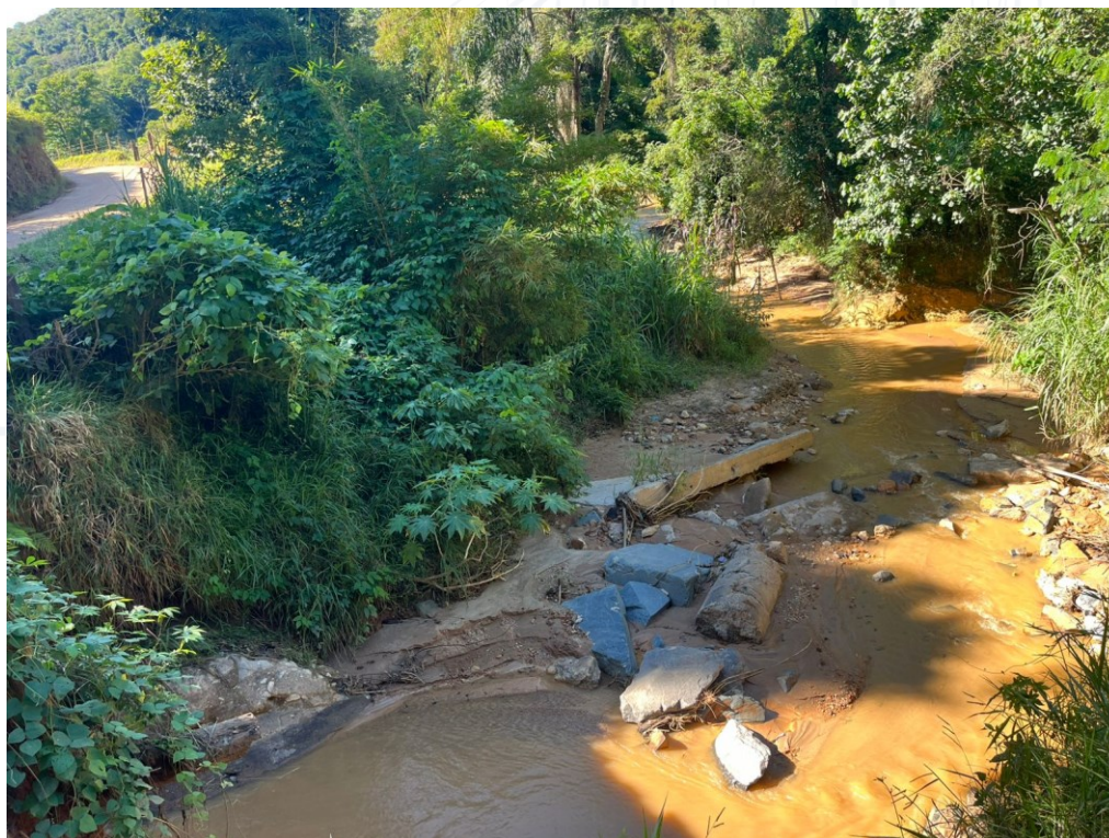
Foto 2: Local de implantação do bueiro ARMCO
