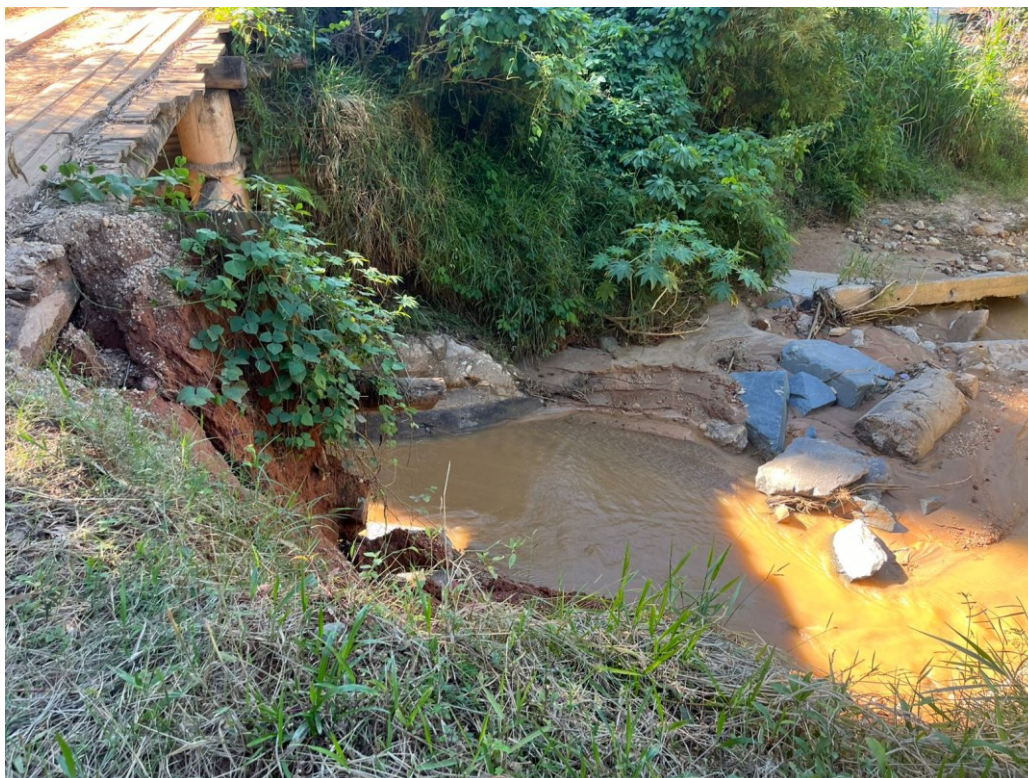
Foto 1: Local de implantação do bueiro ARMCO
