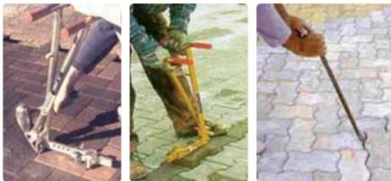
Retirada dos blocos danificados
