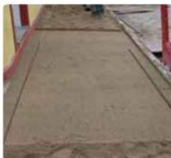
Camada de assentamento
