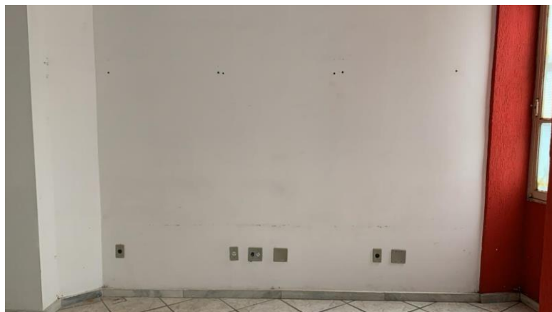
Figura 30: Sala dos fundos - detalhes na pintura
