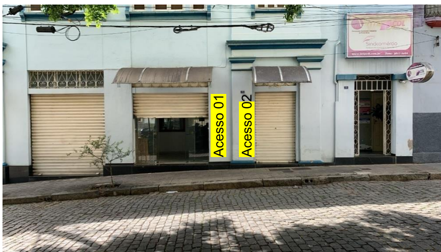
Figura 2: Fachada do imóvel
