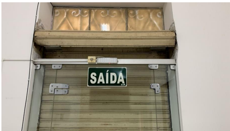
Figura 11: Detalhe na porta de aço (enrolar)
