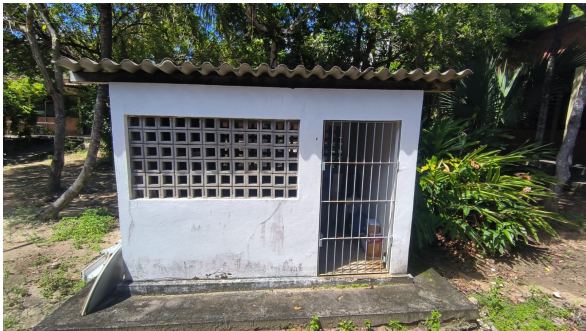
Fig. 1: Abrigo de alvenaria com cobertura, ventilação por cobogós e porta gradeada. Fig. 2: Interior do abrigo com bombonas identificadas (Caráter exemplificativo – não vincula marca ou modelo).
