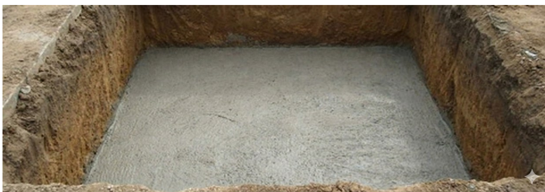
Figura 2 Lastro de concreto.
