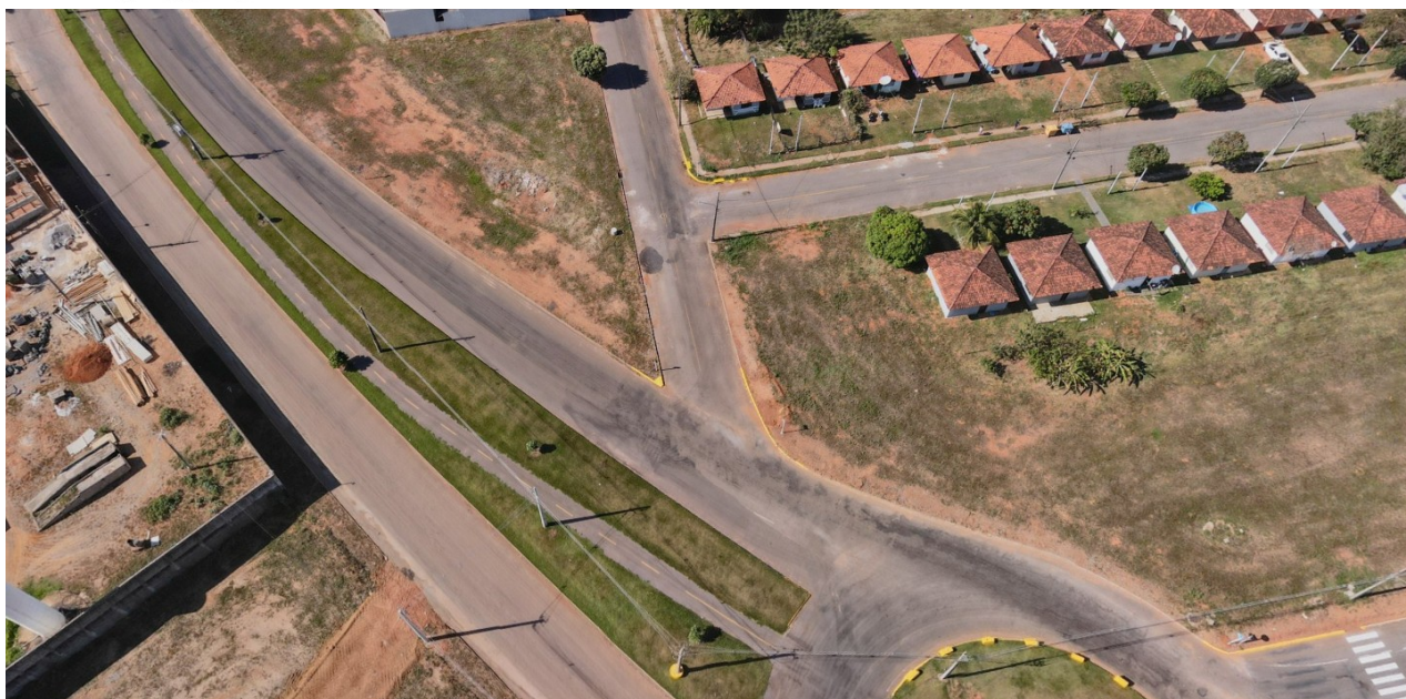
Imagem 1: Avenida da Fé – Coordenadas UTM: 21L617397 - 8558156.
