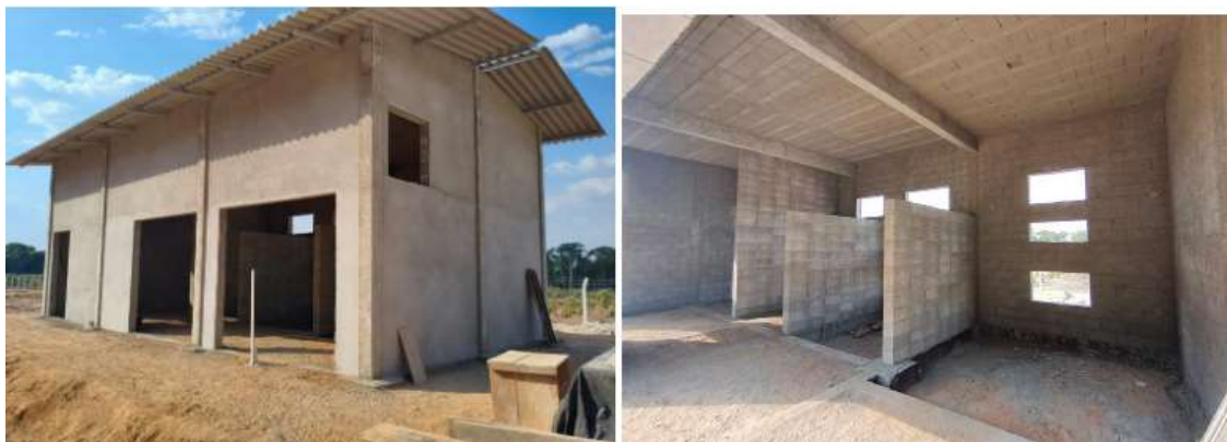
Figura 4 – Subestação em construção (dentro da área da ETE)
