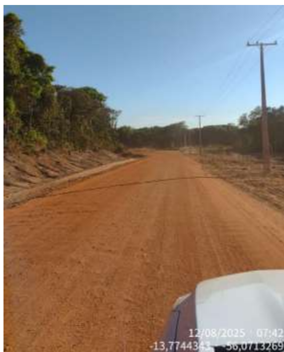
Figura 3 – Local de interligação da rede (prolongamento da Avenida das Arapongas)
