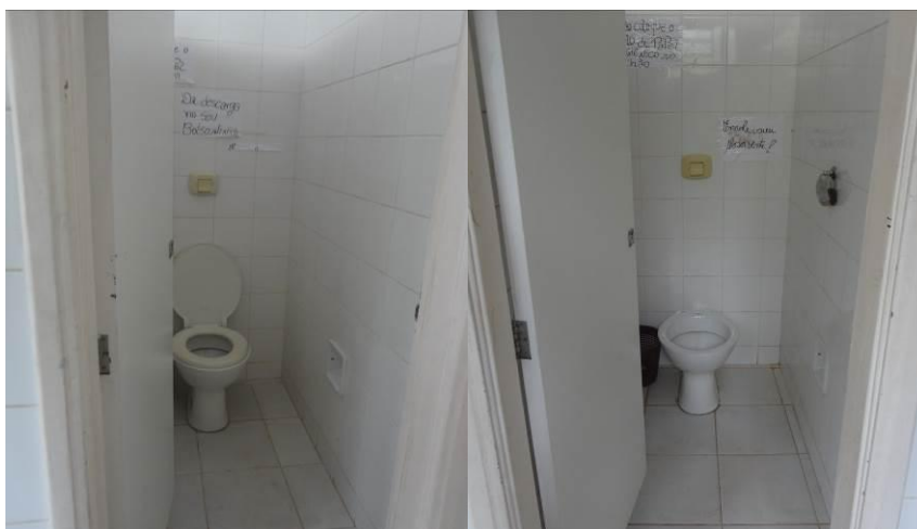
Figura 107 – Vista do Box Desativado – Válvula desativada
