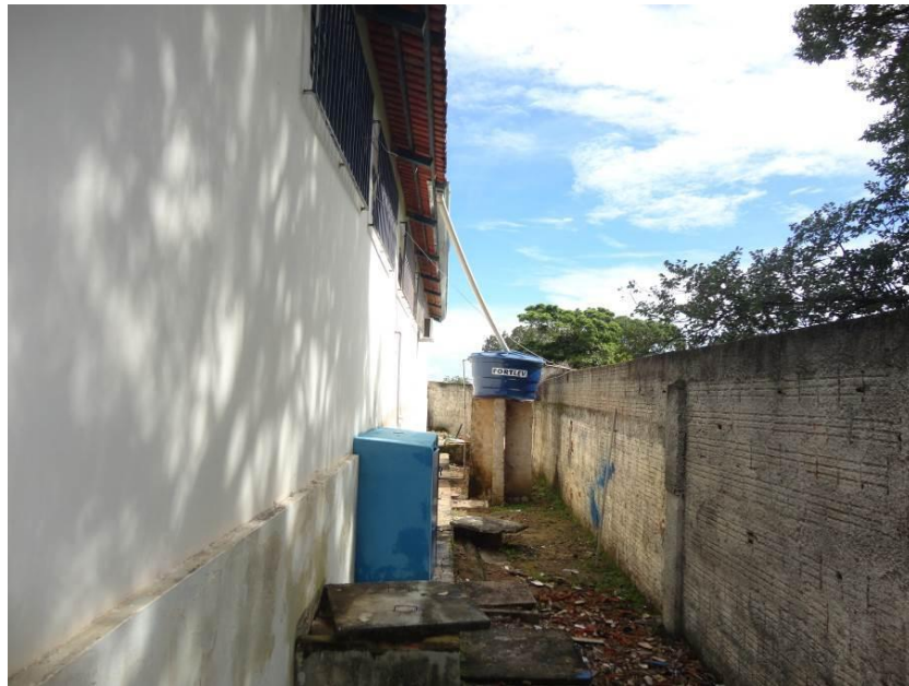
Figura 58 – Vista Externa da Despensa – Abrigo de Gás e Esquadria Metálica
