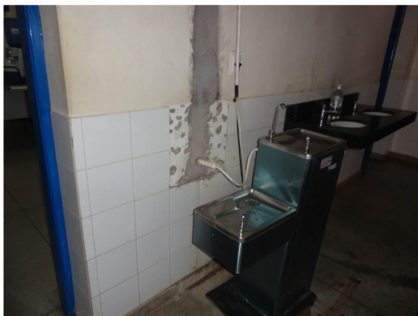
Figura 44 – Vista do Refeitório (Área de Alimentação)
