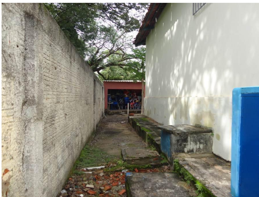
Figura 79 – Vista Externa do Bloco de Sala de Aula
