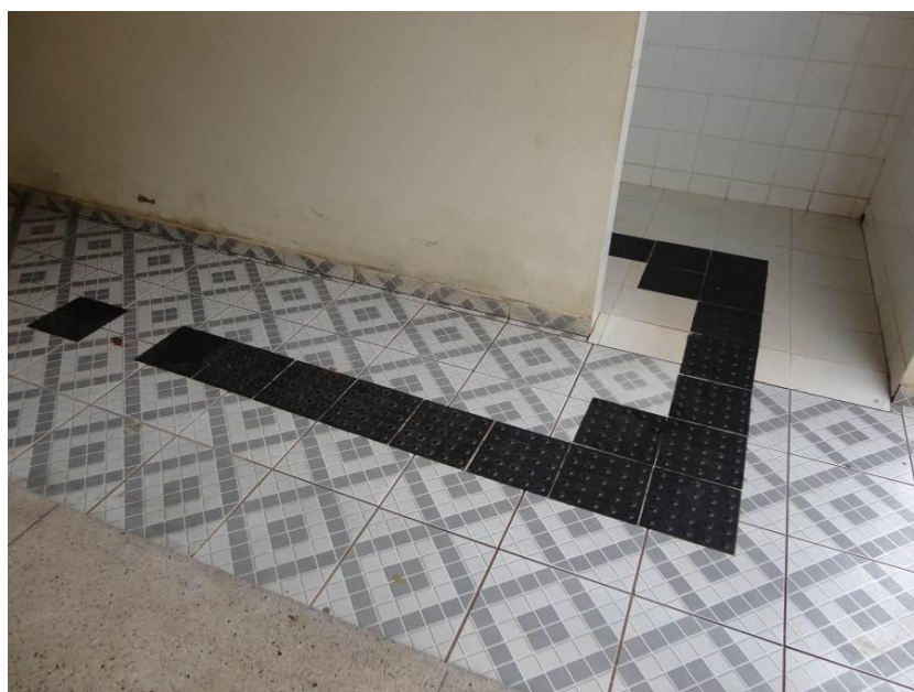
Figura 105 – Vista do Sanitário – Piso Tátil
