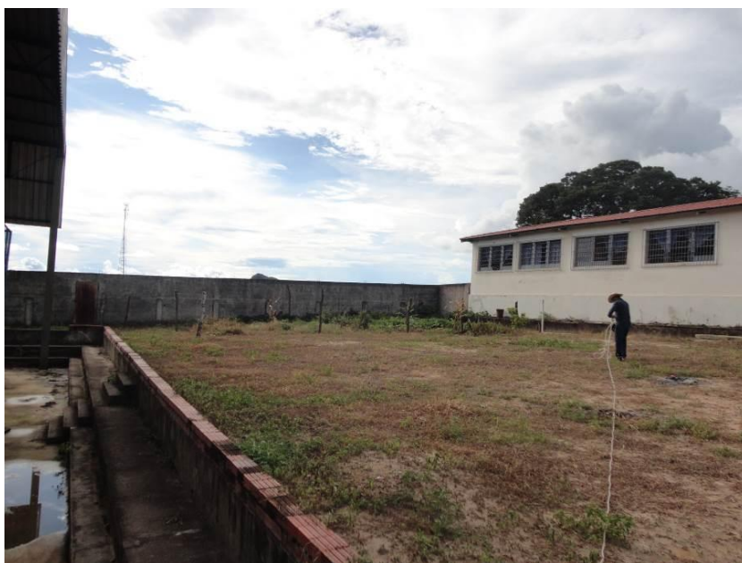
Figura 18: Vista da Arquibancada da Quadra – Contenção da água do terreno
