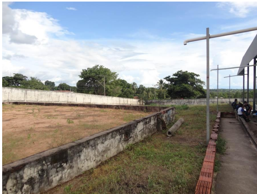
Figura 129 – Vista Interna da Quadra – Muros Chapiscado e Pintado
