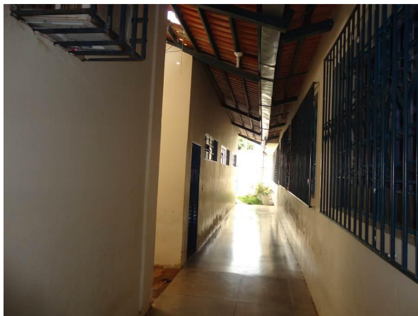
Figura 88 – Vista do Corredor de acesso à Biblioteca
