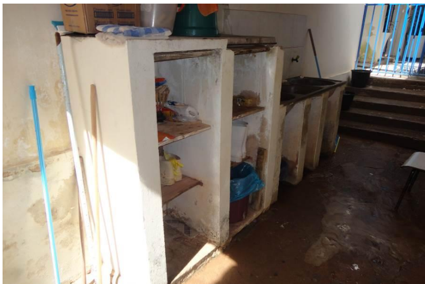
Figura 59 – Vista Interna da Área de Serviço – Espaço Improvisado
