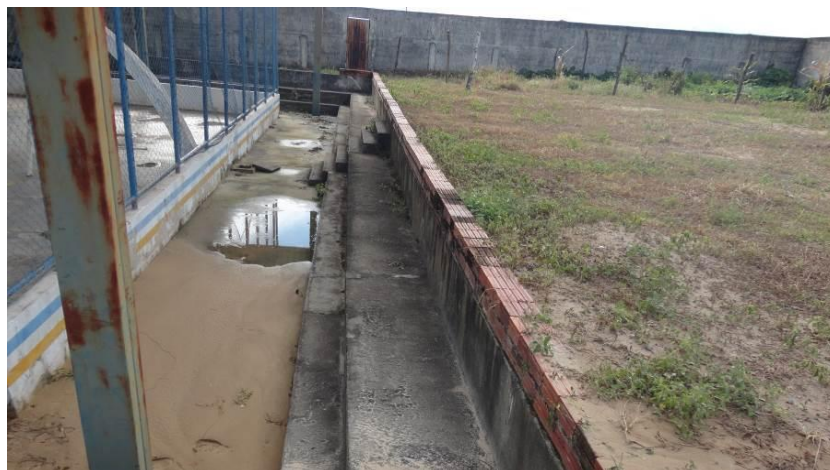
Figura 133 – Vista da Quadra – Arquibancada
