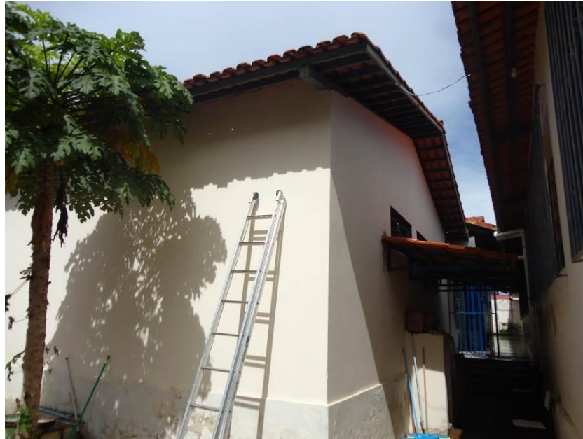
Figura 95 – Vista Externa dos Sanitários dos Alunos – Feminino e Masculino
