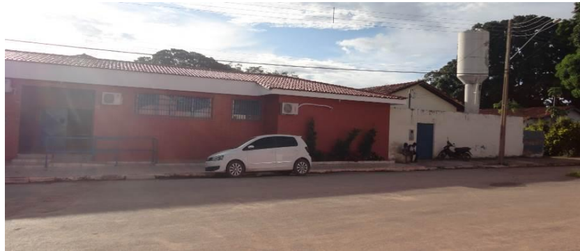
Figura 13: Vista do Portão e Caixa de Água na entrada principal
