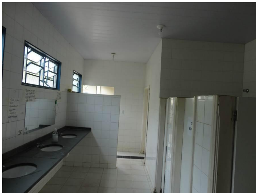
Figura 99 – Vista do Sanitário - Forro em PVC
