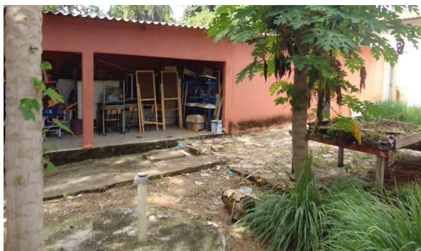
Figura 70 – Vista Externa do Depósito
