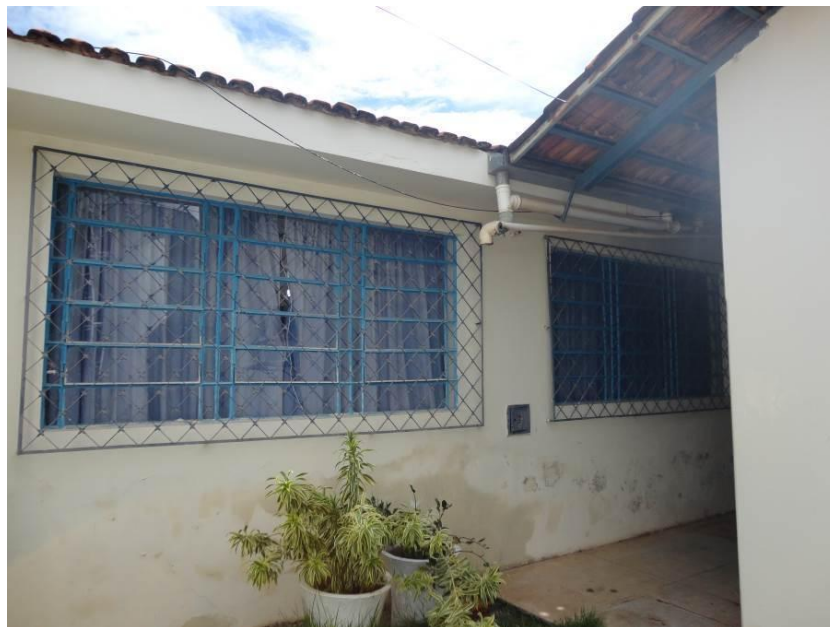
Figura 67 – Vista da Sala da Secretaria (atual)
