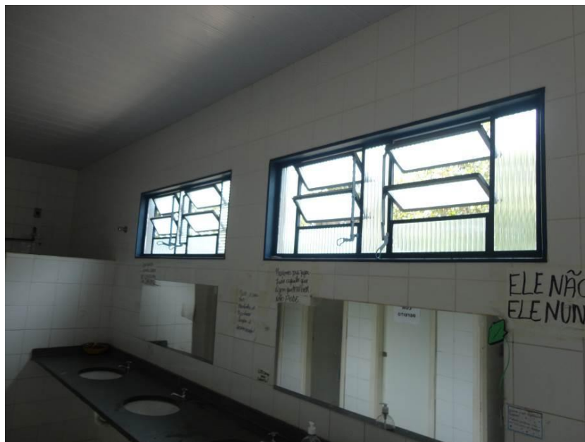
Figura 97 – Vista Interna do Sanitário – Esquadrias Metálicas com Vidro Canelado (Fantasia)
