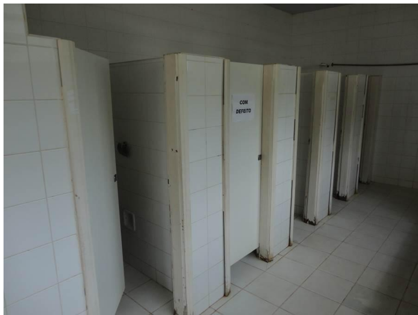
Figura 100 – Vista Interna do Sanitário – Divisória de Alvenaria e Portas de Madeira
