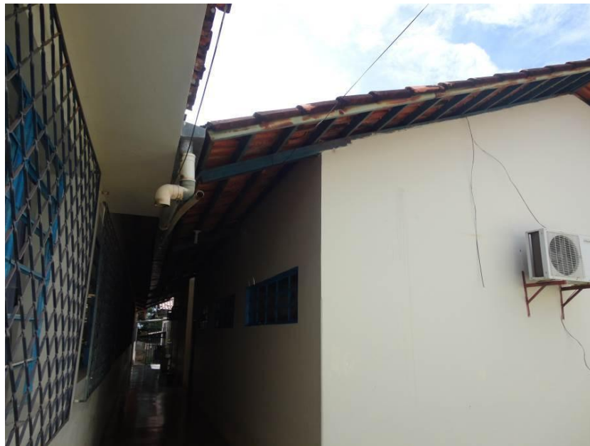
Figura 89 – Vista Externa da Biblioteca
