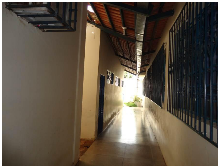
Figura 26 – Vista do Corredor - Bicicletário Improvisado
