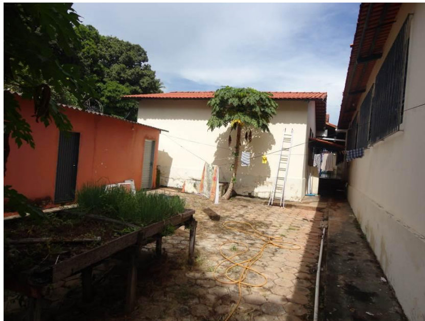
Figura 94 – Vista Externa dos Sanitários dos Alunos – Feminino e Masculino
