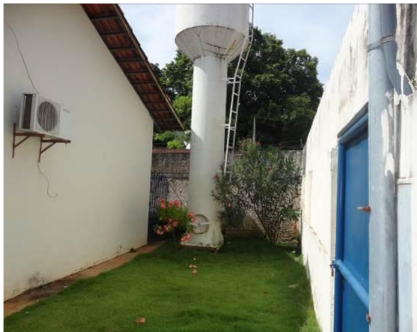
Figura 111 – Vista da Caixa d' Água tipo Taça
