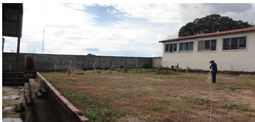
Figura 134 – Vista Interna da Quadra – Acessos na Mureta
