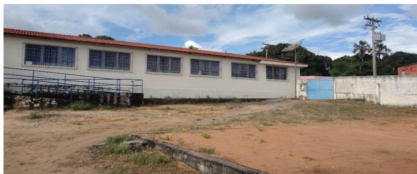
Figura 8: Vista da fachada frontal do colégio
