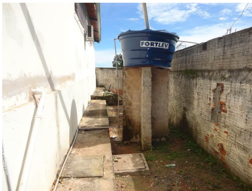
Figura 112 – Vista da Caixa de Água de Polietileno
