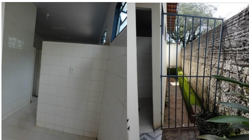
Figura 106 – Vista Interna do Sanitário e do Gradil do Corredor
