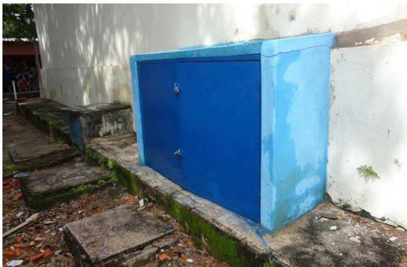
Figura 47 – Vista do Abrigo de Gás
