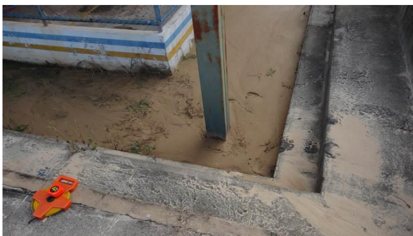
Figura 132 – Vista da Quadra – Arquebancada
