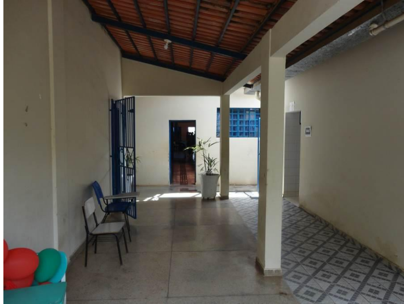
Figura 93 – Vista Interna da Varanda – Sanitário das Alunas
