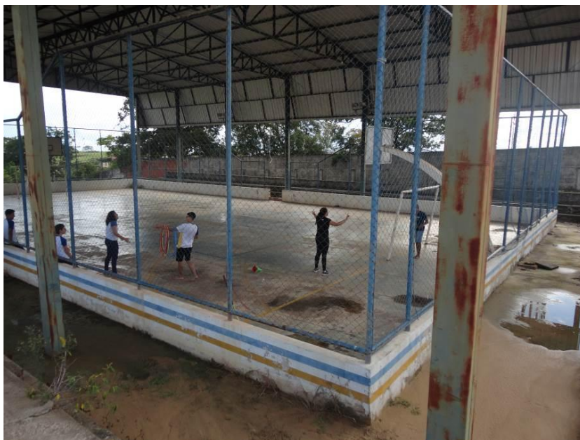
Figura 139 – Vista geral dos Refletores – Cobertura da Quadra
