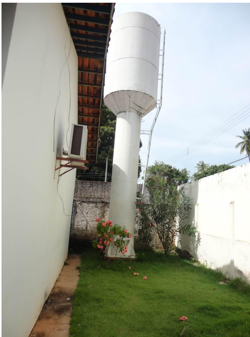
Figura 110 – Vista da Caixa d' Água tipo Taça
