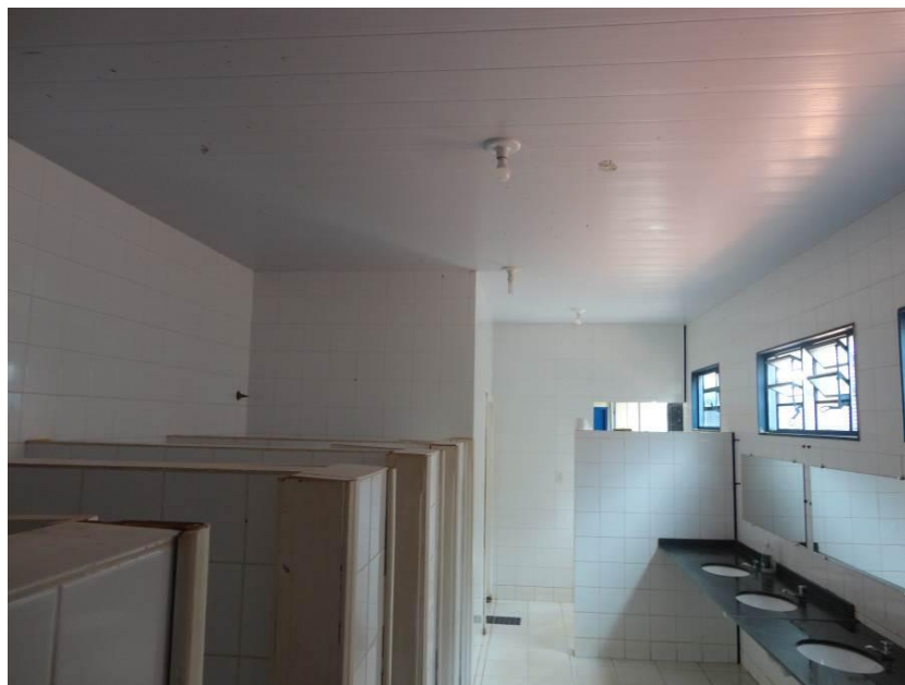
Figura 104 – Vista Interna do PNE – Entrada do Sanitário
