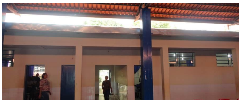
Figura 37 – Vista do Refeitório (Área de Alimentação)
