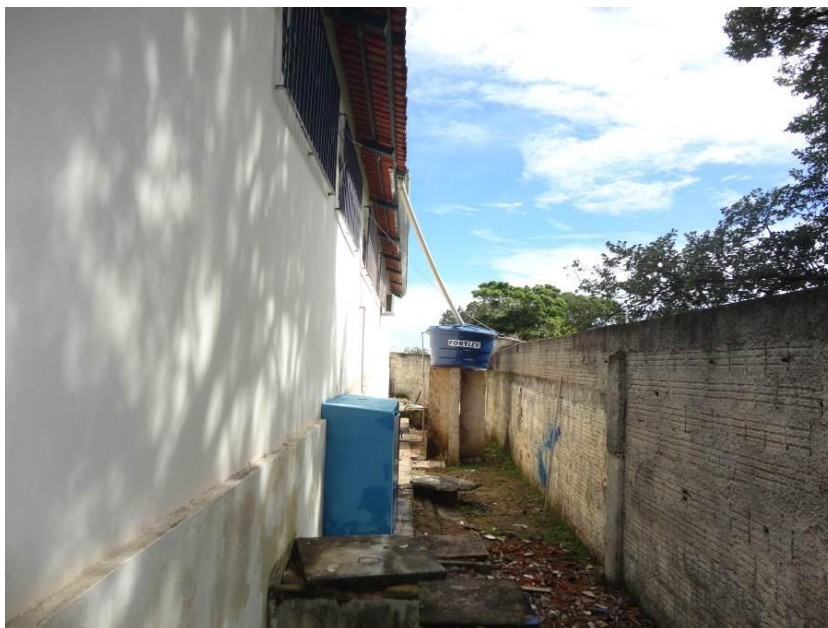
Figura 48 – Vista externa da Cozinha e Muro dos Fundos (lado do campo)
