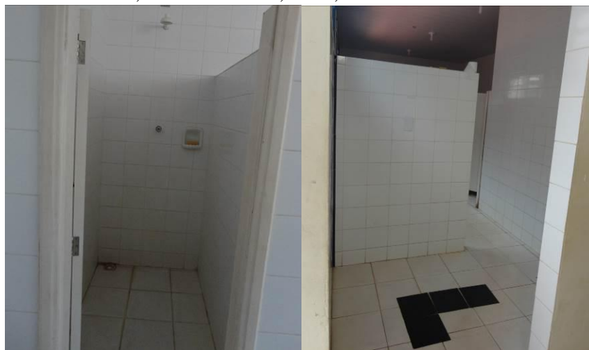
Figura 109 – Vista Interna do Box e da Entrada do Sanitário
