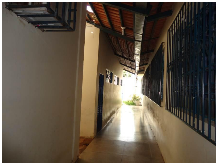
Figura 116 – Corredor que vai ao encontro à Caixa d' Água tipo Taça
