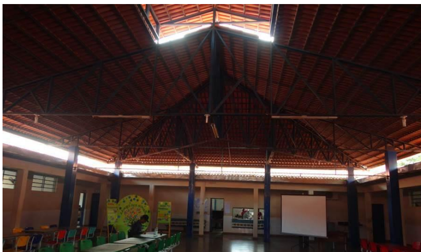
Figura 40 – Vista do Pátio Coberto – ao fundo o Passa Prato da Cantina
