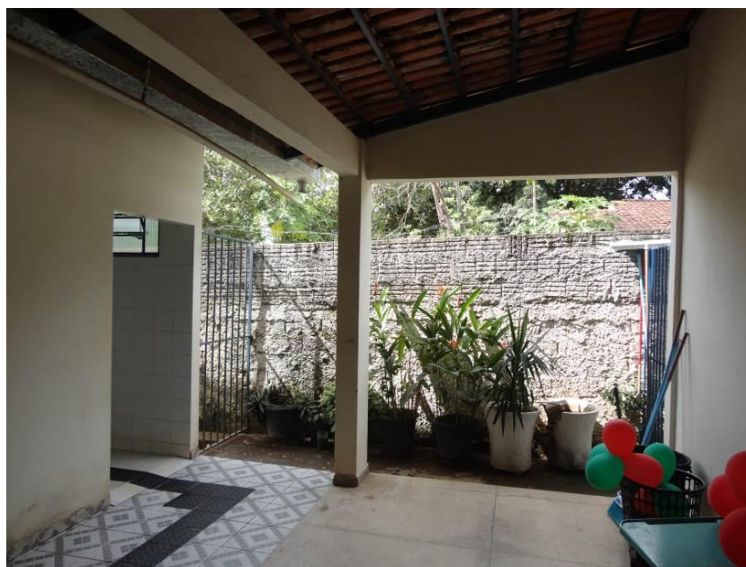
Figura 92 – Vista Interna da Varanda – Sanitário das Alunas
