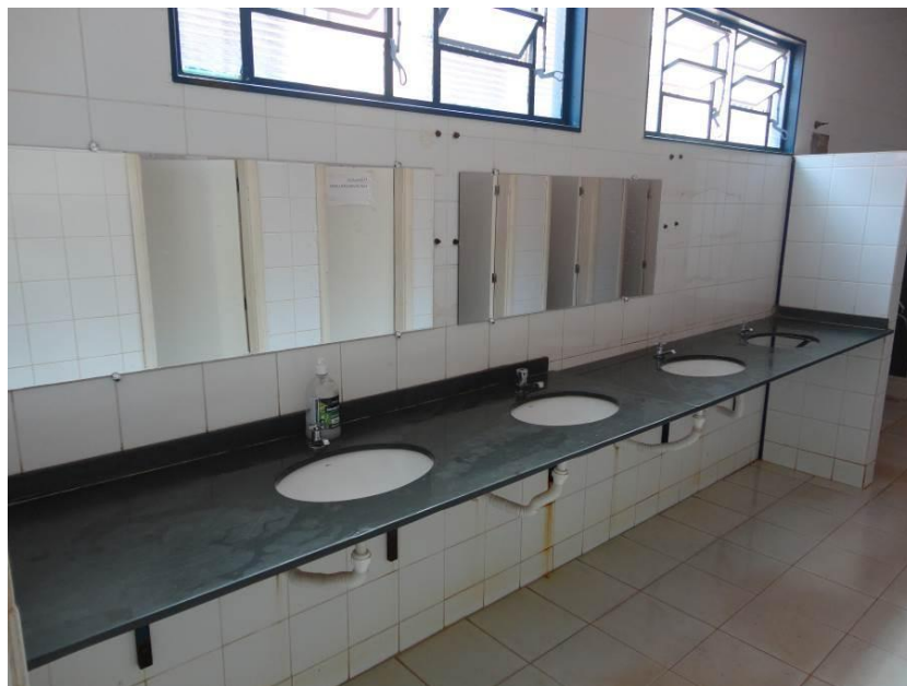
Figura 102 – Vista Interna do Sanitário – Bancadas em Ardósia
