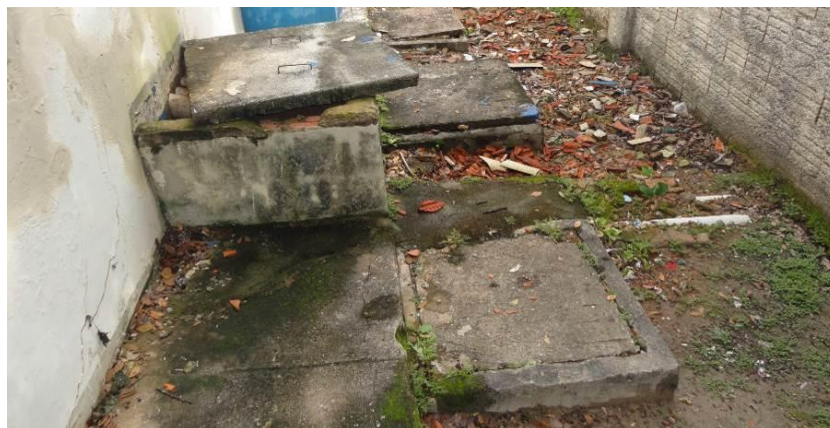
Figura 113 – Vista das Caixas de Passagens de Alvenaria
