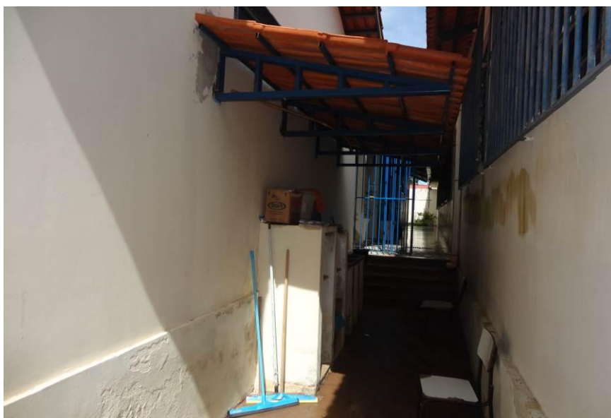
Figura 60 – Vista Interna da Área de Serviço – Espaço Improvisado
