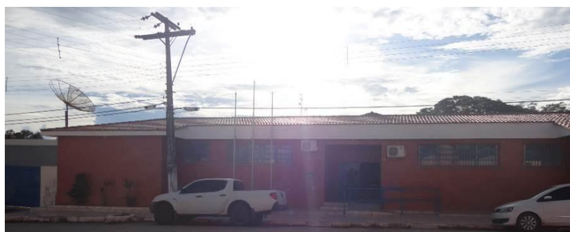
Figura 7: Vista da fachada frontal do colégio
