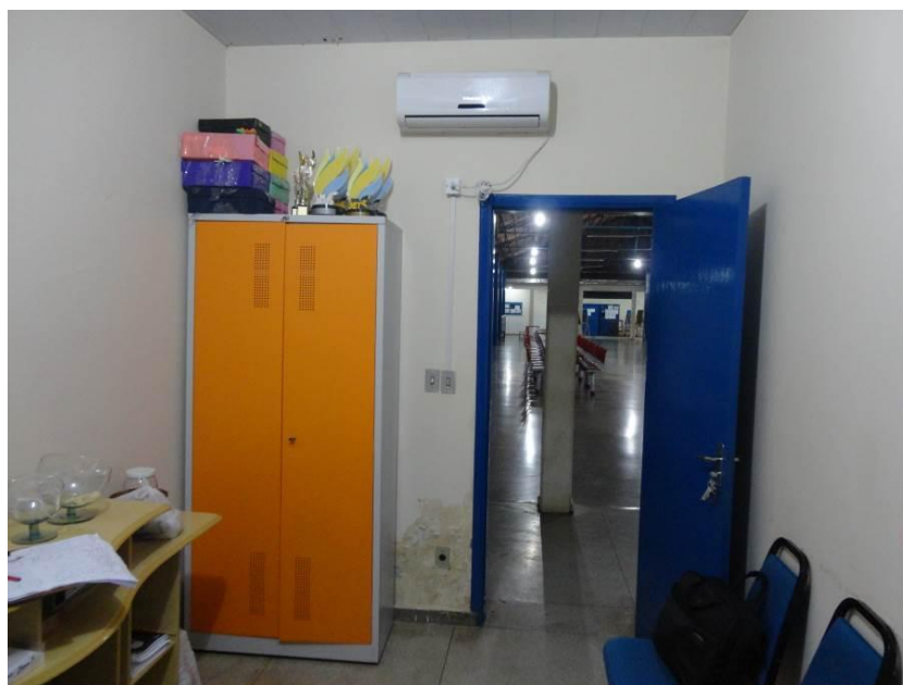
Figura 66 – Diretoria (do projeto) – Janelas com Vidros Fixos, sem ventilação
