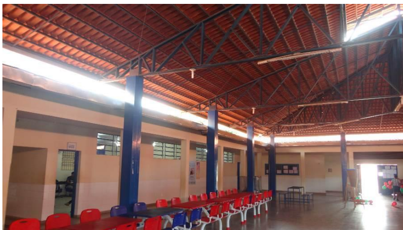
Figura 42 – Vista do Pátio Coberto – Sistema de Calhas
