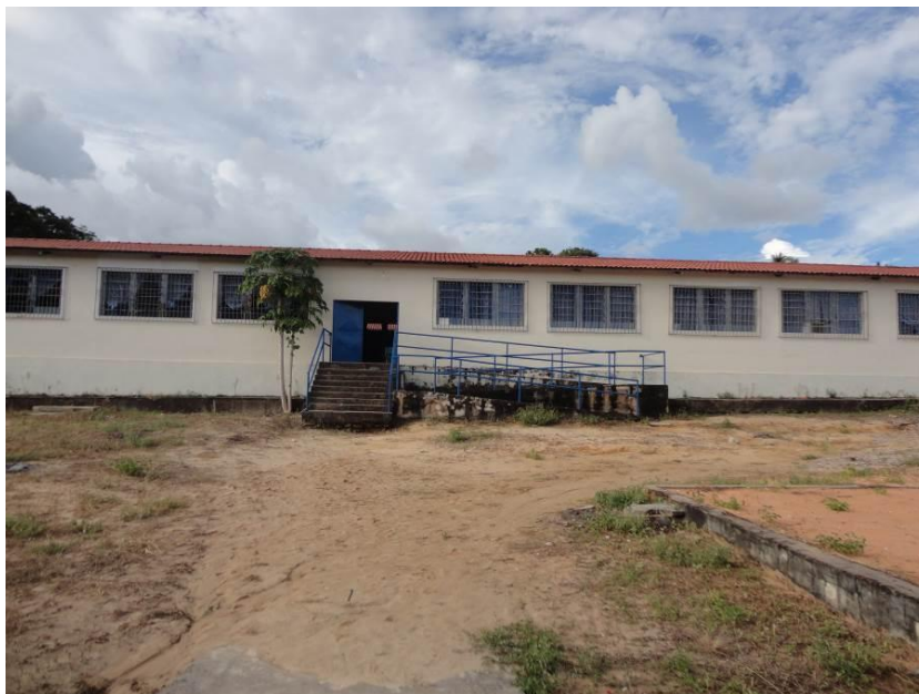
Figura 49 – Vista da Escada e da Rampa de Acesso a Quadra
