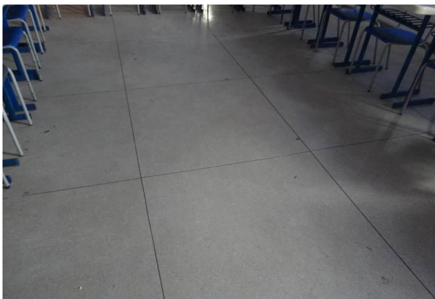
Figura 72 – Sala de Aula – Piso em Granitina
