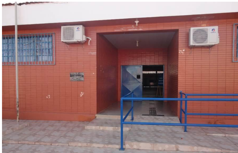
Figura 6: Vista da fachada frontal do colégio
