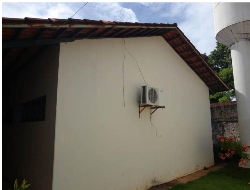
Figura 90 – Vista Externa da Biblioteca
