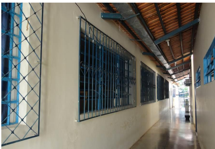
Figura 77 – Vista Externa da Sala – Janelas com Proteção em Grade
