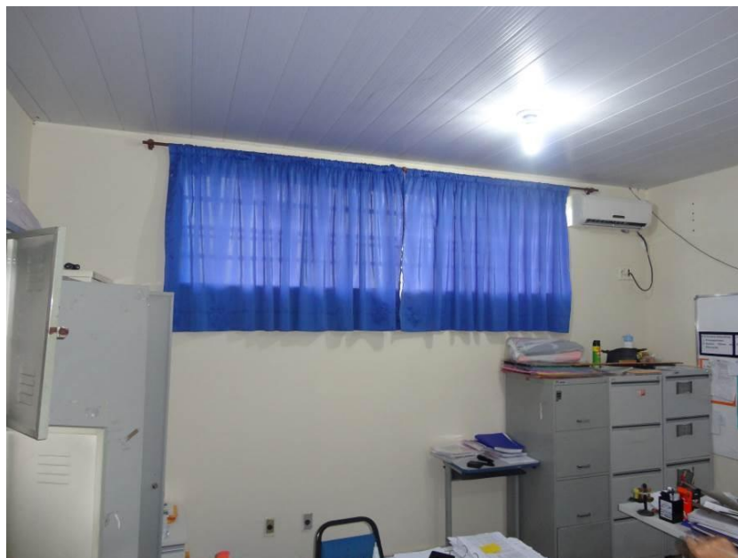
Figura 63 – Vista da Sala Administrativa - Climatizado
