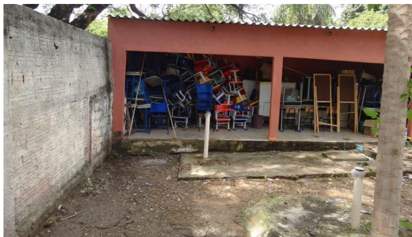
Figura 69 – Vista Externa do Depósito
