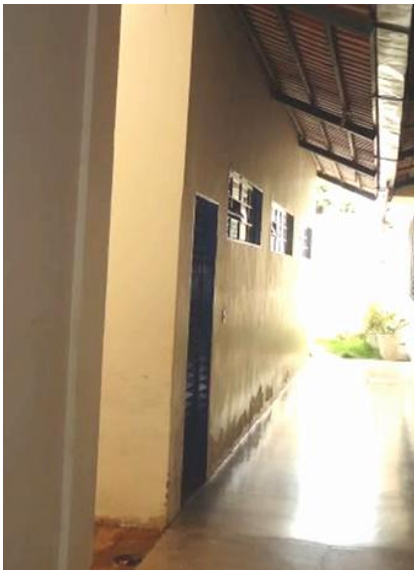
Figura 86 – Vista do Corredor entre os Blocos – Acesso do Labin
