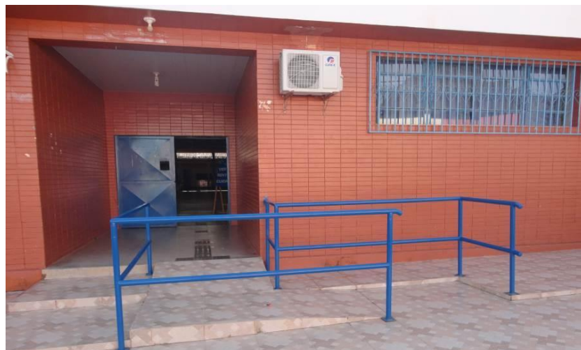
Figura 9: Fachada Principal da UE – Rampa, Escada e Guarda-corpo
