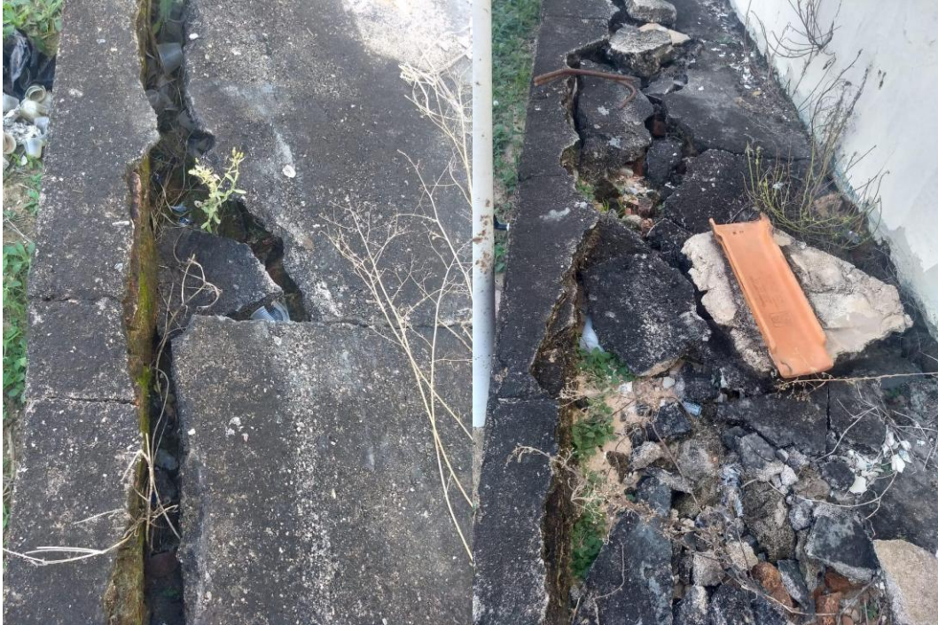
Figura 23 – Vista externa da Sala de Aula – Calçadas
