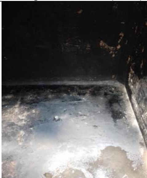
Figura 05 – Interior do reservatório
