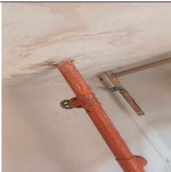
Figura 09 – Tubulação incendio
