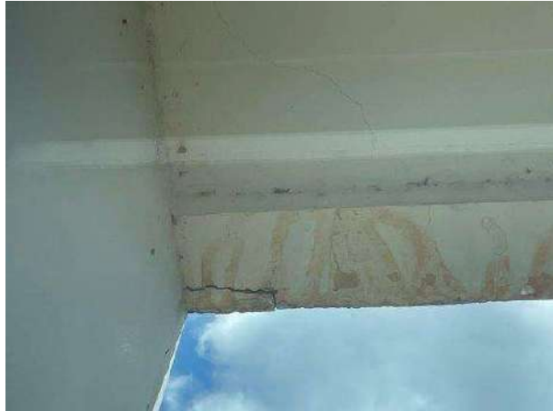
Foto 42 – Vista inferior da Viga da Fachada próximo a entrada da rampa
