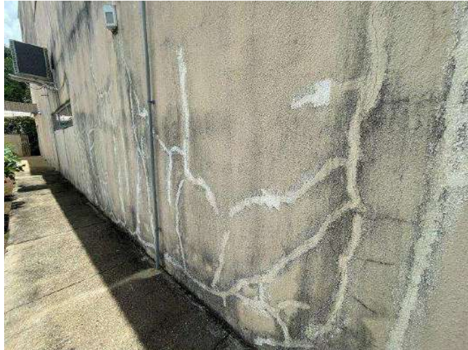
Foto 72 - Vista externa da parede norte do Tribula do Juri
