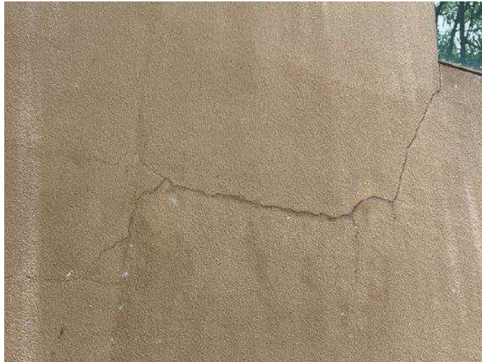
Foto 45 – Vista da Fachada na região da Escada 02
