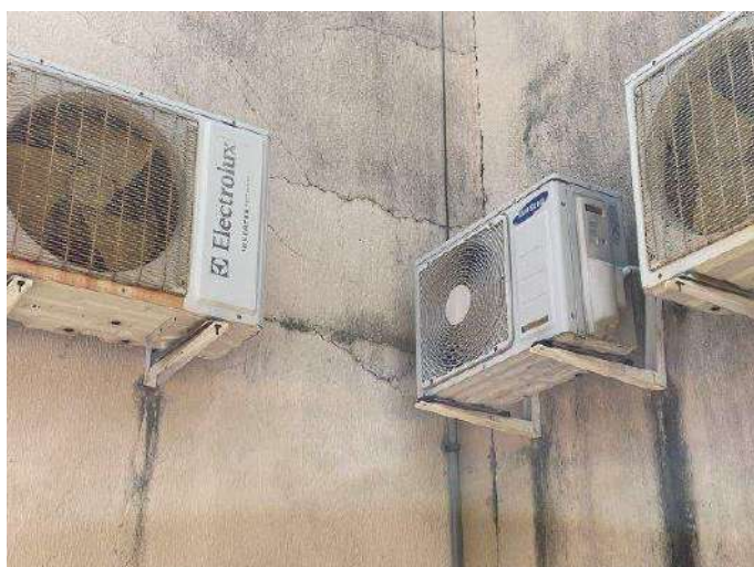
Foto 77 – Vista externa do trecho entre Copa/Cozinha com Espera Policial
