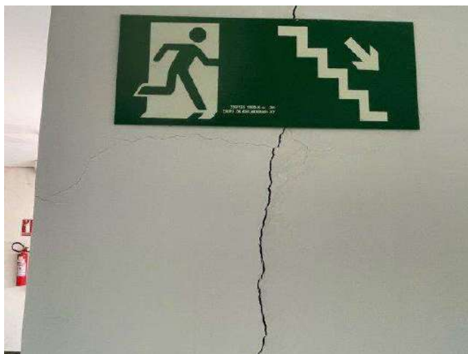
Foto 30 – Escada 03 com área privativa – Pav. Superior
