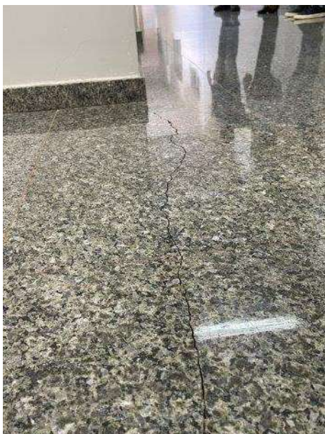
Foto 31 – Escada 03 com área privativa – Pav. Superior
