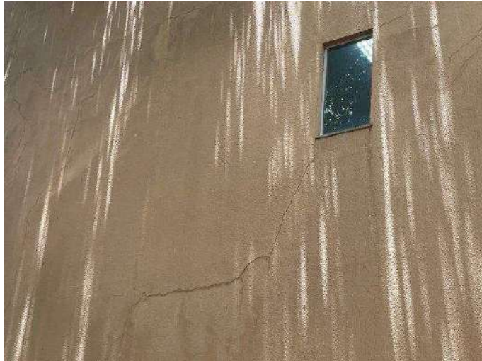
Foto 48 – Vista da Fachada na região da Escada 02
