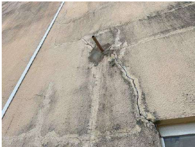
Foto 70 – Vista externa da parede norte do Tribula do Juri
