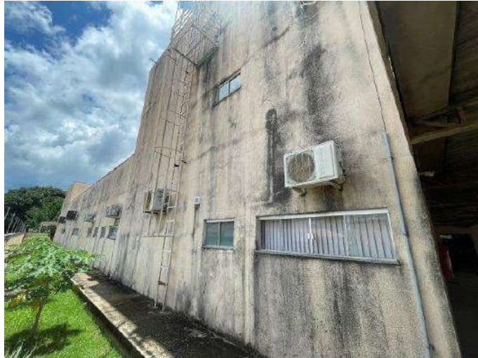
Foto 75 – Vista da fachada norte Guarda-Celas e Tribunal do Juri
