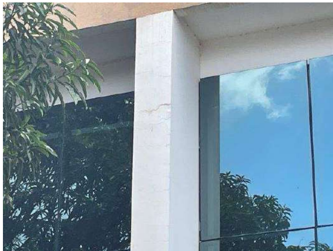
Foto 49 – Pilares da fachada na região da Jardim 03
