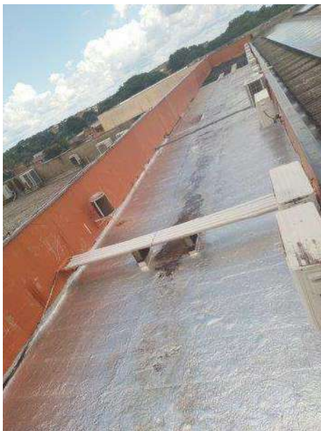
Foto 43 – Laje Impermeabilizada no centro da edificação
