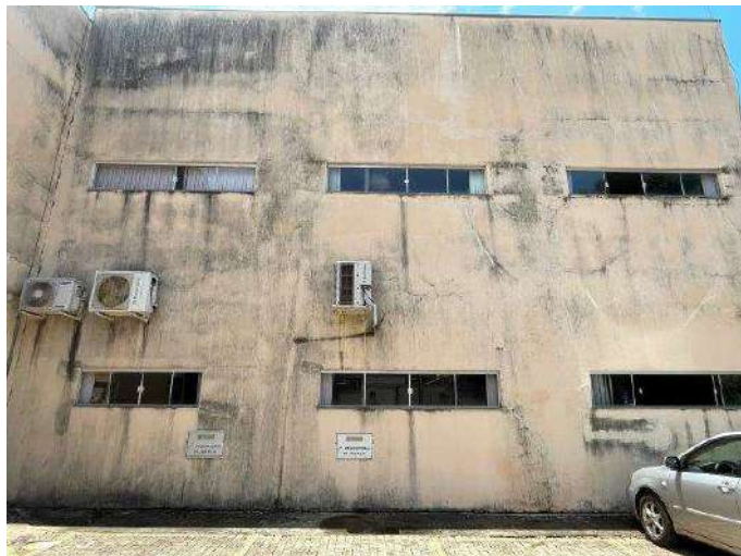
Foto 76 – Vista norte da região a Copa/Cozinha/Amb. de descanso
