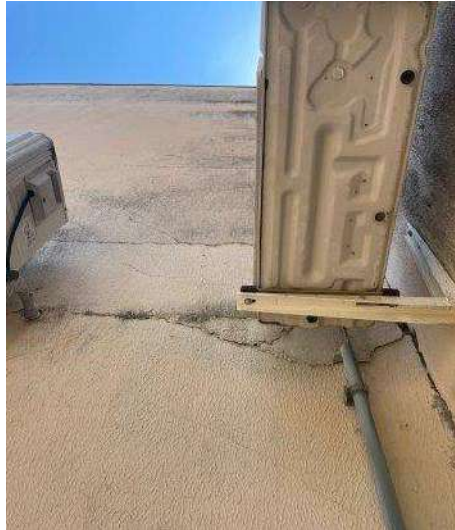
Foto 78 – Vista externa do trecho entre Copa/Cozinha com Espera Policial
