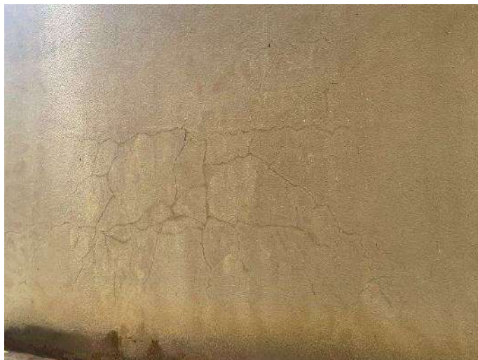
Foto 46 – Vista da Fachada na região da Escada 02
