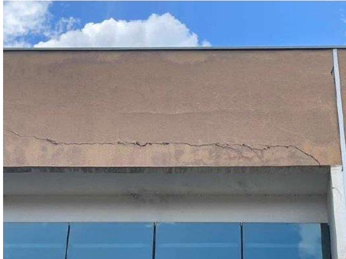
Foto 51 – Vista da Fachada região do jardim 03 e circulação vertical
