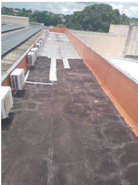
Foto 44 – Laje Impermeabilizada no centro da edificação
