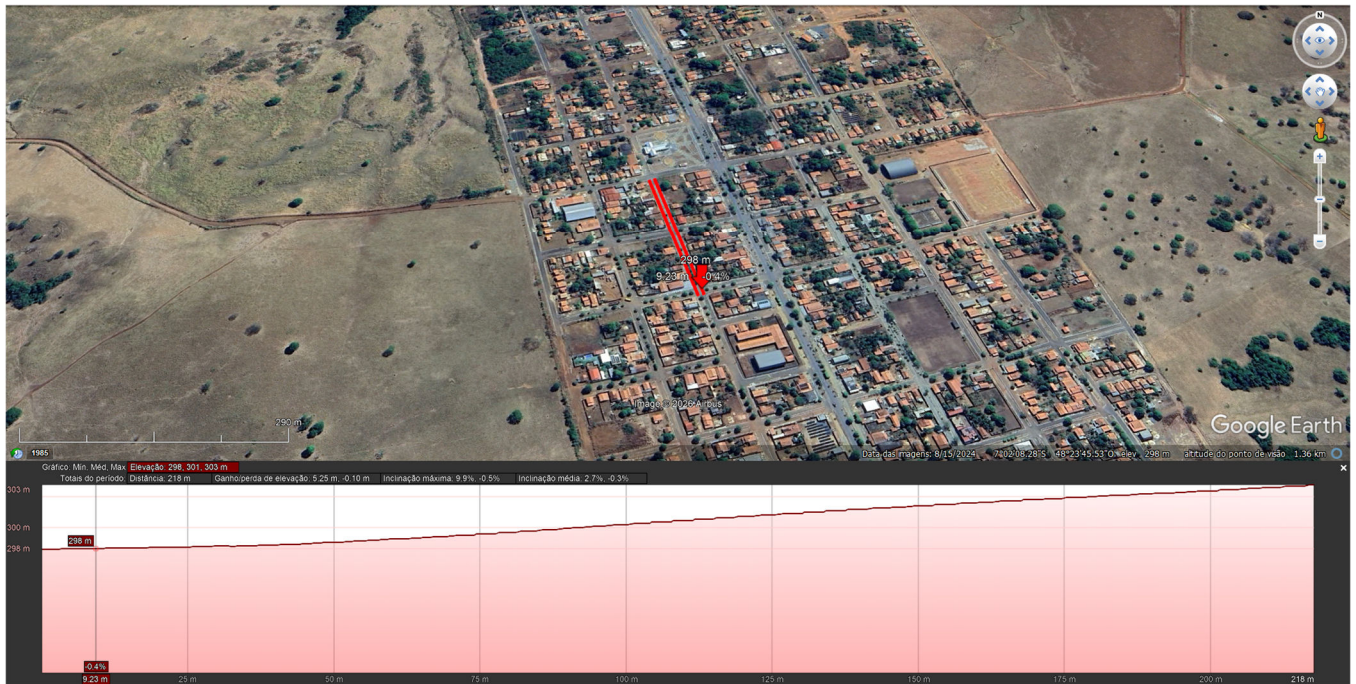
Rua José Pedro de Oliveira – TRECHO II e TRECHO III
