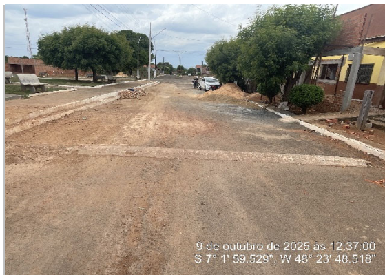
RUA RECAPEAMENTO CBUQ -7.033342, -48.396744
