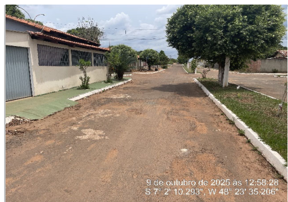
RUA RECAPEAMENTO CBUQ -7.036367, -48.392997
