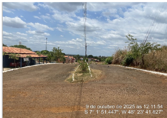
RUA RECAPEAMENTO CBUQ -7.030772, -48.394797
