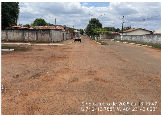
RUA RECAPEAMENTO CBUQ -7.036681, -48.395764
