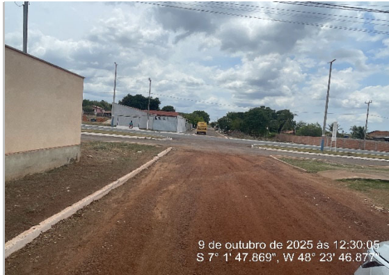
RUA RECAPEAMENTO CBUQ -7.030042, -48.396633
