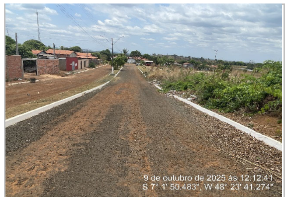
RUA RECAPEAMENTO CBUQ -7.030336, -48.394839
