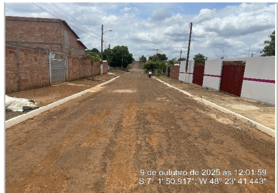
RUA RECAPEAMENTO CBUQ -7.030911, -48.39512
