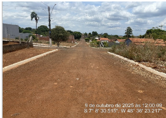
RUA RECAPEAMENTO CBUQ -7.030806, -48.39515
