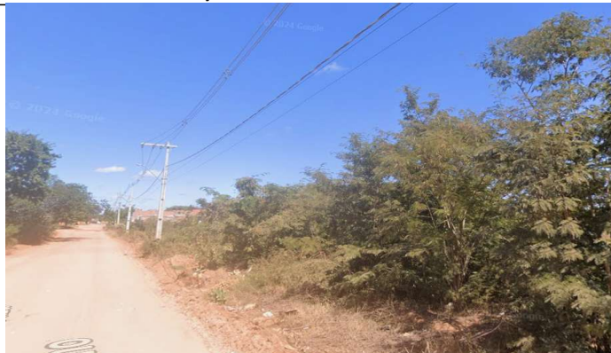
FOTO 06 - ANTES DA EXECUÇÃO DA OBRA
