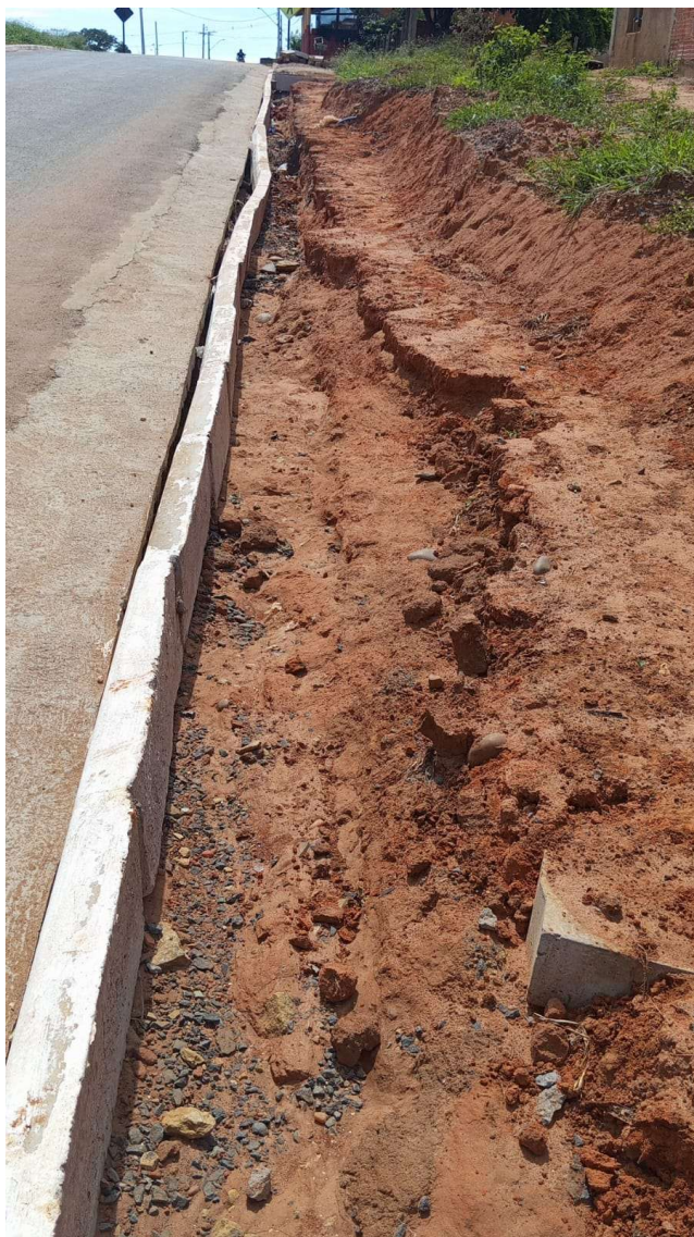
FOTOGRAFIA 02 – LOCAL EXECUÇÃO DE CALÇADA
