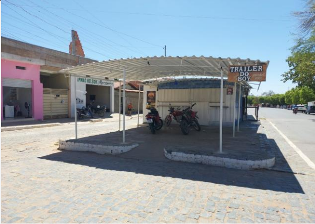
Descrição da fotografia: PONTO DE APOIO DA PRAÇA PRINCIPAL Foto: 7 Data da fotografia: 03/10/2025
