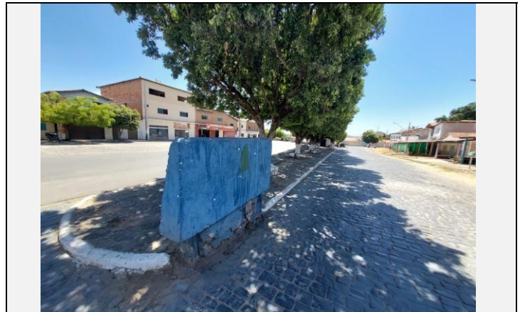
Descrição da fotografia PONTO DE APOIO DA PRAÇA PRINCIPAL Foto 22 Data da fotografia 03/10/2025
