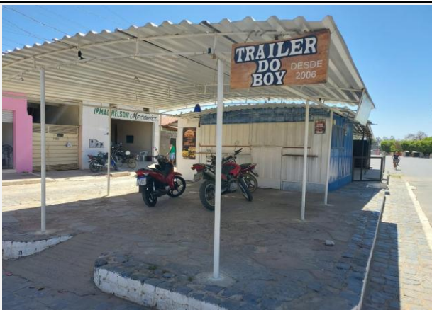
Descrição da fotografia: PONTO DE APOIO DA PRAÇA PRINCIPAL Foto: 11 Data da fotografia: 03/10/2025
