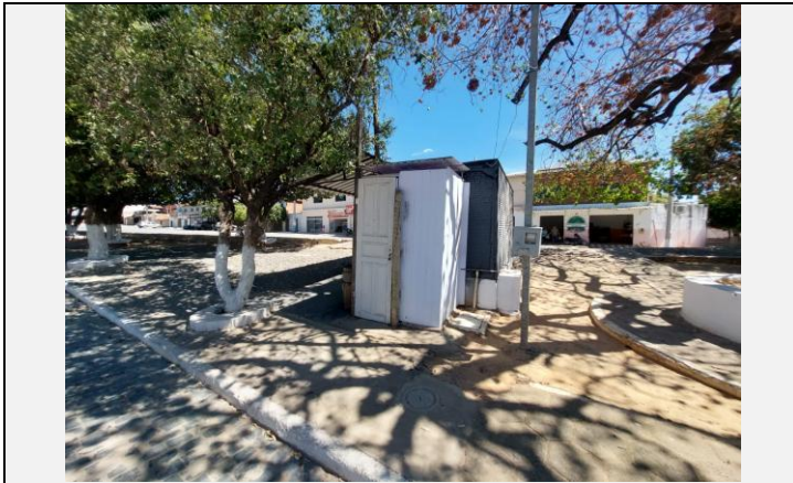
Descrição da fotografia Foto Data da fotografia PONTO DE APOIO DA PRAÇA PRINCIPAL 27 03/10/2025
