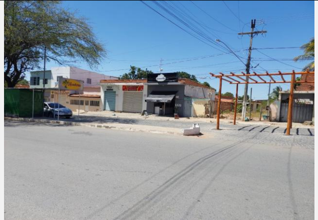
Descrição da fotografia: PONTO DE APOIO DA PRAÇA PRINCIPAL Foto: 8 Data da fotografia: 03/10/2025
