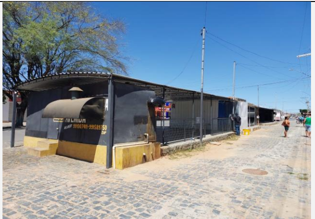
Descrição da fotografia: PONTO DE APOIO DA PRAÇA PRINCIPAL Foto: 12 Data da fotografia: 03/10/2025
