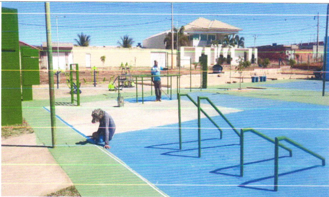
Foto 05: Execução de pintura em piso externo da Academia da Saúde na Lagoa do Aconchego, serviço de Pintor .
