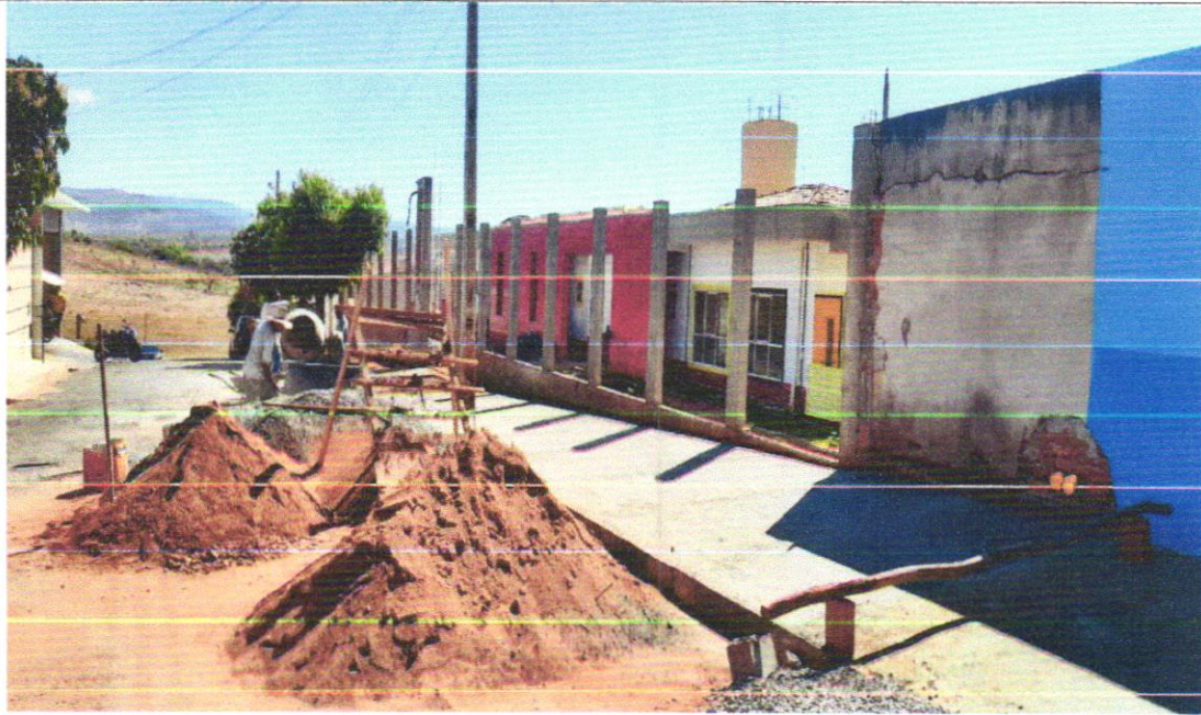
Foto 06: Preparação de concreto não estrutural e execução de contra piso na Pro infância, serviço de Ajudante e Pedreiro.
