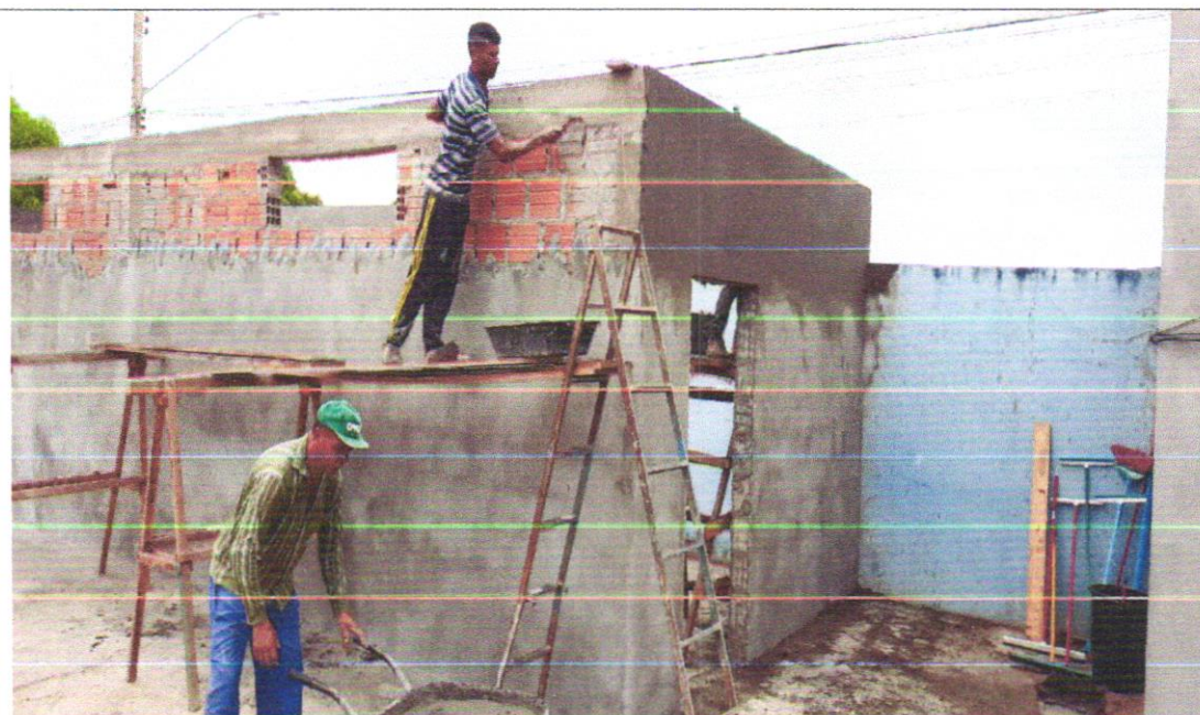
Foto 09: Execução de alvenaria na construção de garagem de motocicletas da Escola Municipal, serviço de Pedreiro .
