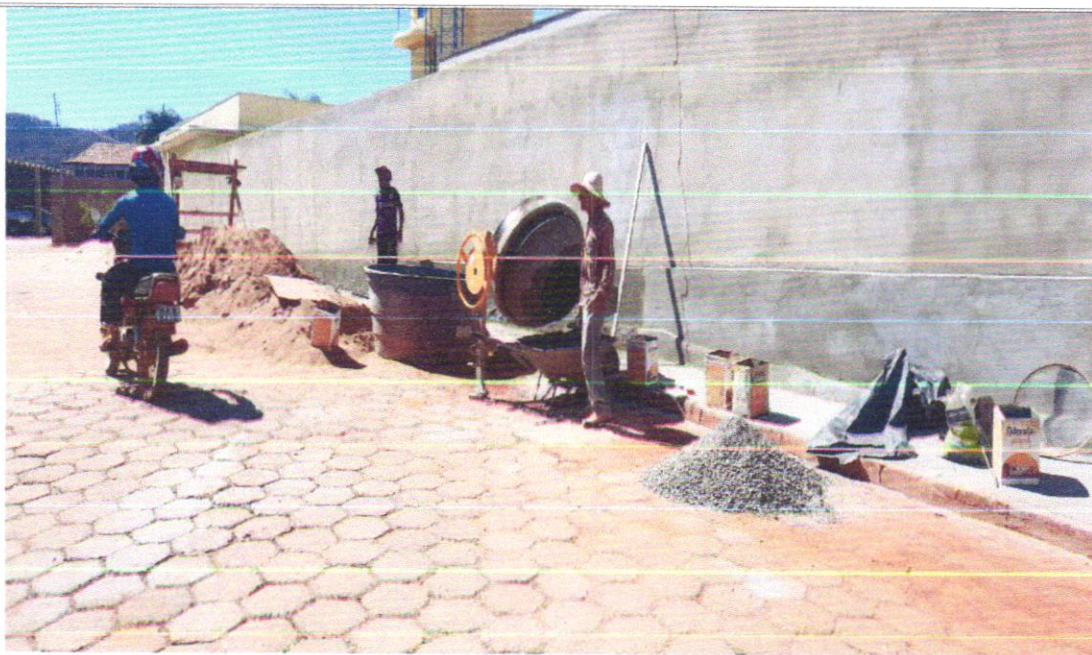
Foto 04: Preparação de argamassa para reboco no muro da Pro infância, serviço de Ajudante .
