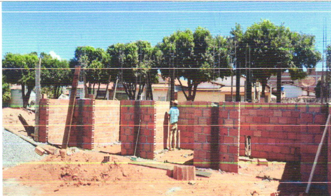
Foto 03: Execução de alvenaria no Mercado Municipal, serviço de Pedreiro .
