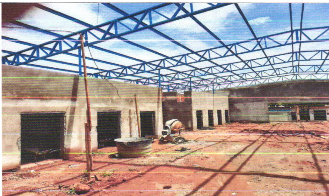
Foto 14: Execução e montagem de cobertura metálica para o Mercado Municipal, serviço de Serralheiro .
