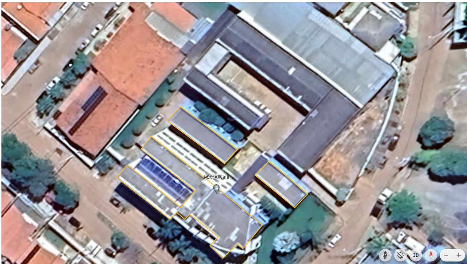
Foto Aérea - Sede Administrativa do SAE – Demarcação do telhado a ser substituído.
