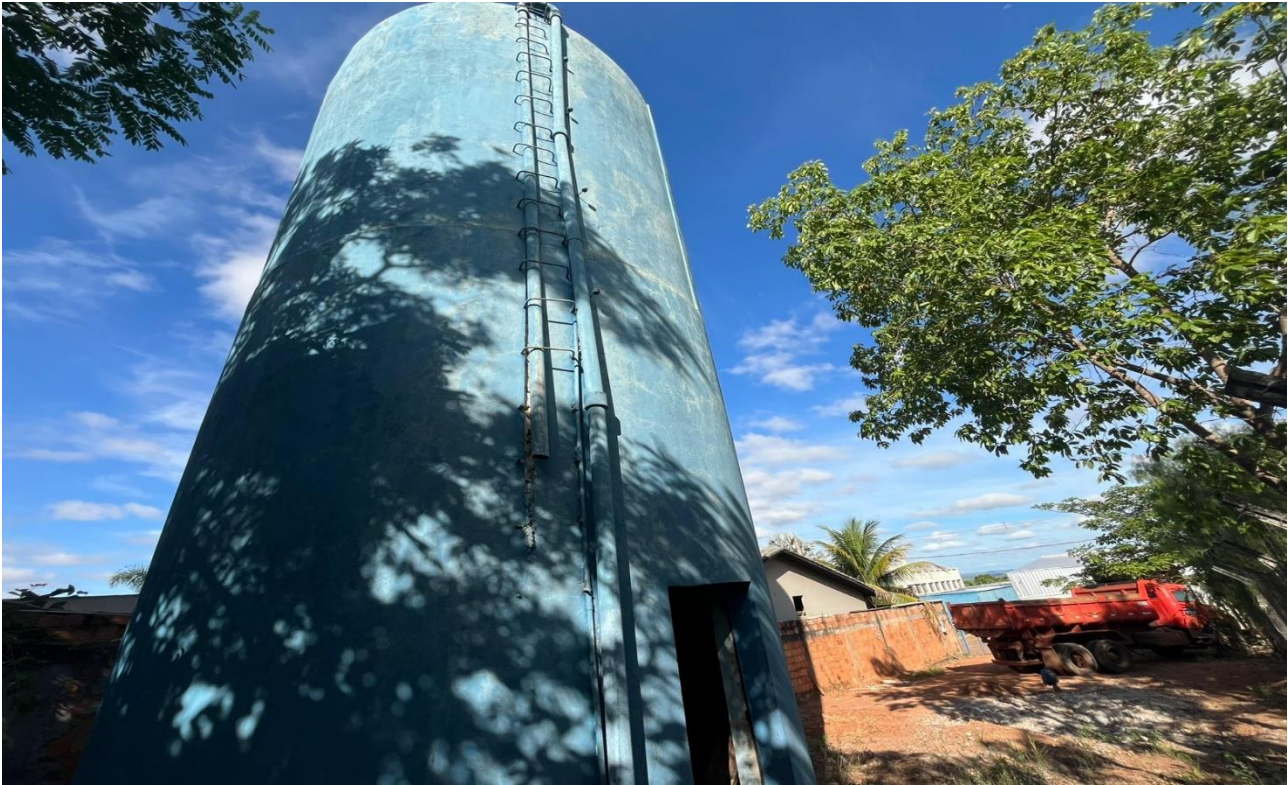
RESERVATORIO A SER DEMOLIDO 16°22'47.65"S - 46°53'2.07"O
