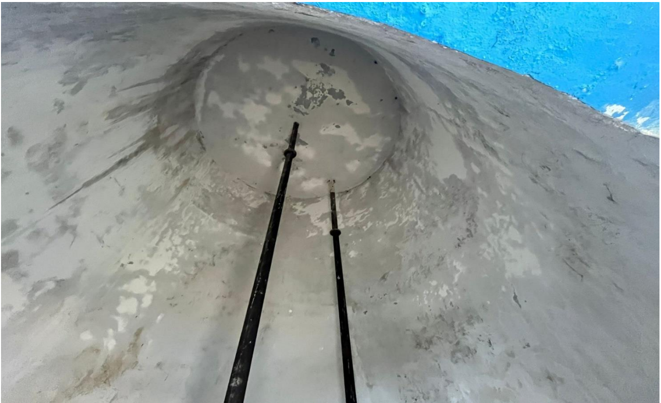
RESERVATÓRIO A SER DEMOLIDO 16°22'47.65"S - 46°53'2.07"O
