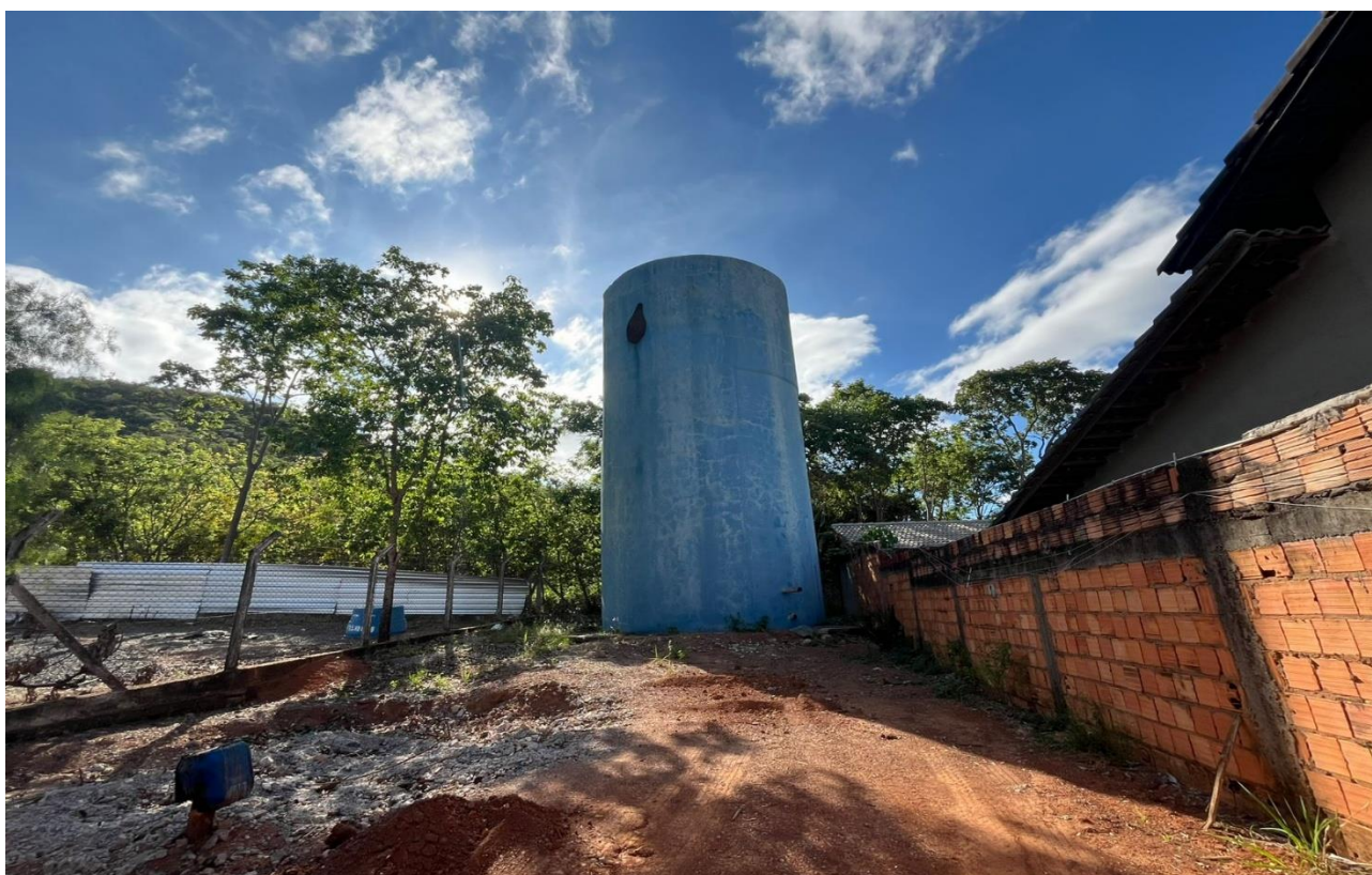
LOCAL DA OBRA E RESERVATORIO A SER DEMOLIDO 16°22'47.65"S - 46°53'2.07"O
