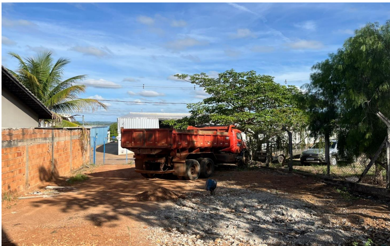
LOCAL DA OBRA 16°22'47.65"S - 46°53'2.07"O
