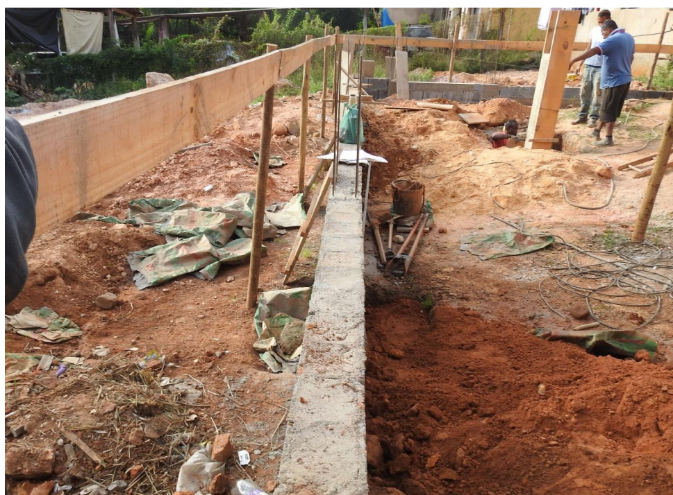
Foto 4: Fundações e vigas baldrame executadas.
