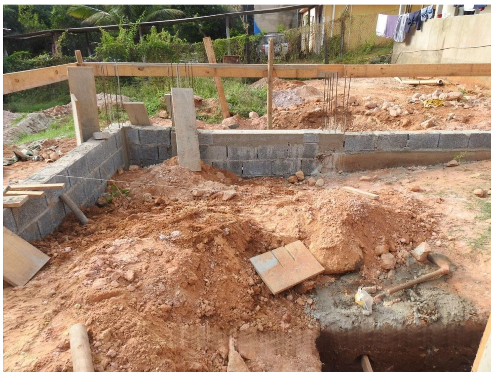
Foto 3: Fundações e vigas baldrame executadas.
