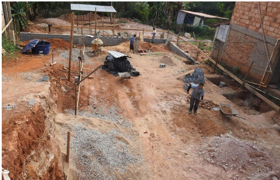
Foto 1: Vista geral da área com fundações executadas.
