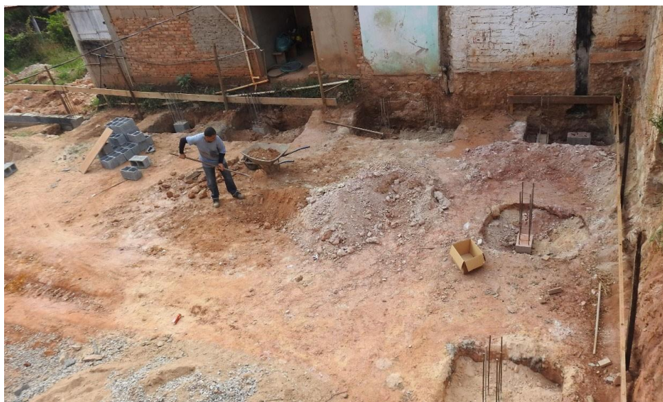
Foto 2: Fundações concretadas e aterradas.
