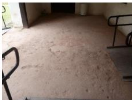
Imagem 10 – Rampas para acessibilidade instaladas em 2010. Arquivo IPHAN SP.
