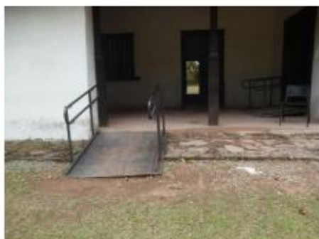
Imagem 9 - Rampas para acessibilidade instaladas em 2010. Arquivo IPHAN SP.
