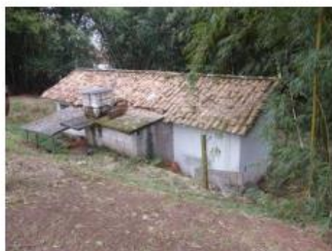
Imagem 14 – Casa do caseiro construída em 1978. Arquivo IPHAN SP.
