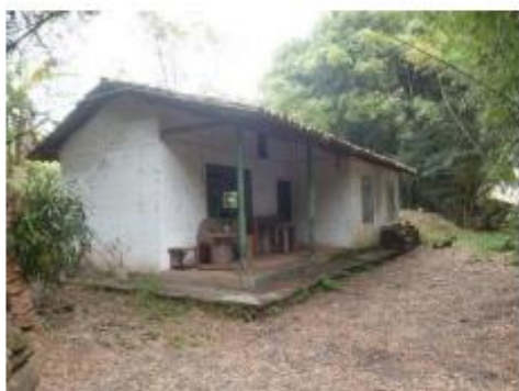
Imagem 13 – Casa do caseiro construída em 1978. Arquivo IPHAN SP.
