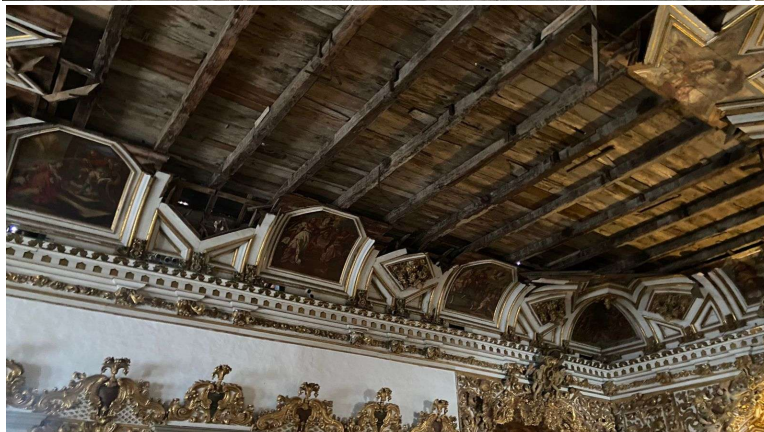
Vista da situação da nave a partir da entrada principal da igreja (esquerda) e vista do trecho central do forro.
