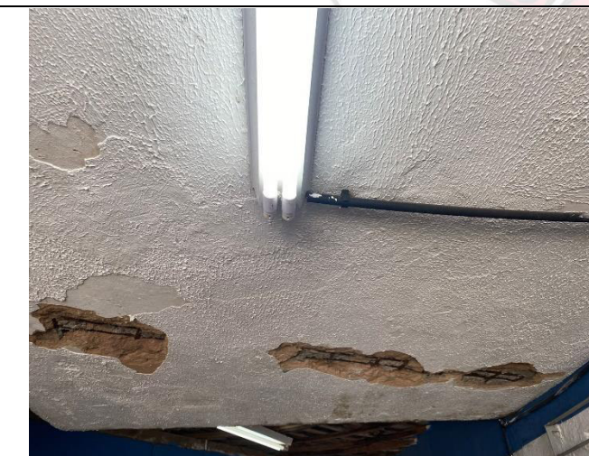
LAJE CENTRAL DO PÁTIO – ARMADURA EXPOSTA
