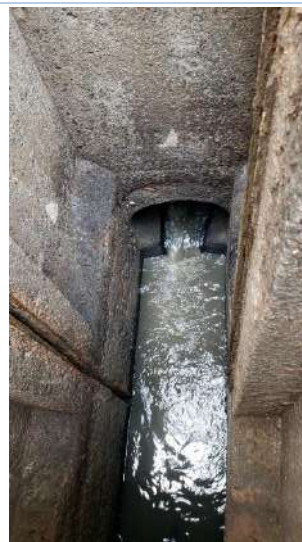
Figura 31: Gradeamento vista interna
