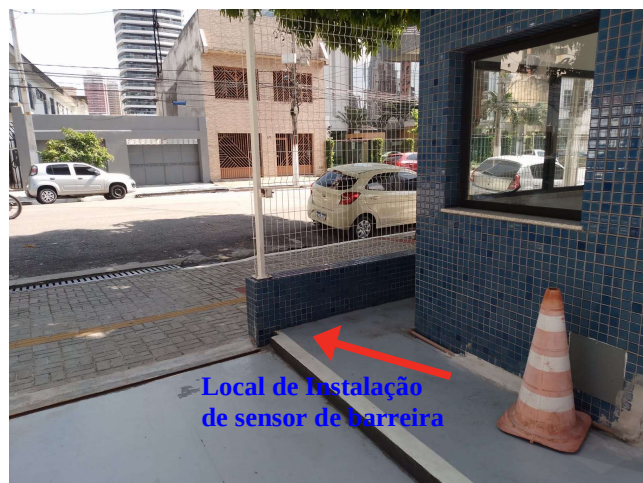
Imagem 03 – local de instalação do sensor de barreira
