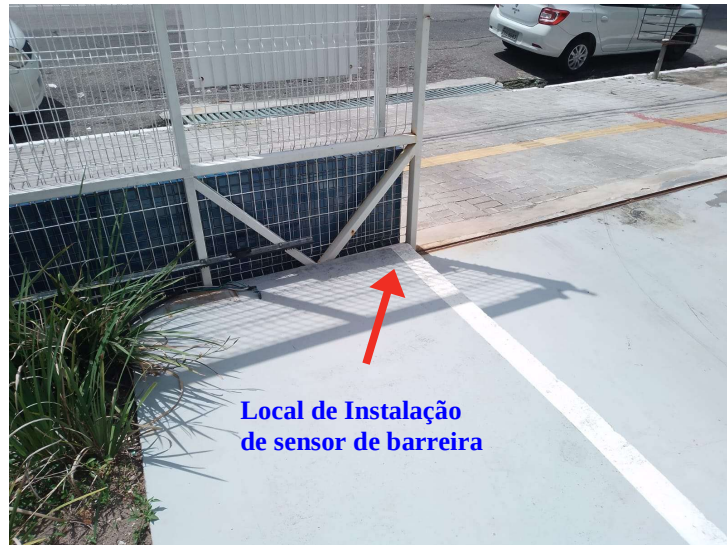
Imagem 08 - local de instalação do sensor de barreira
