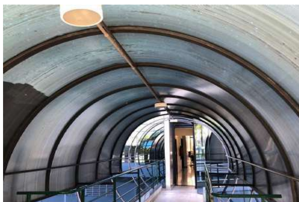
Figura 3: Demonstração da parte interna da passarela.
