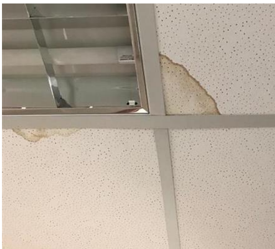
Placas de forro em fibra mineral danificadas, instalada na PTM de Juiz de Fora.
