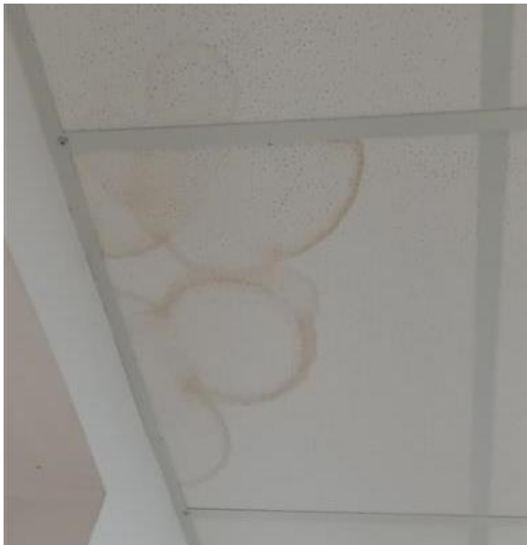
Placas de forro em fibra mineral danificadas ou retiradas, nas instalações da PTM de Coronel Fabriciano.
