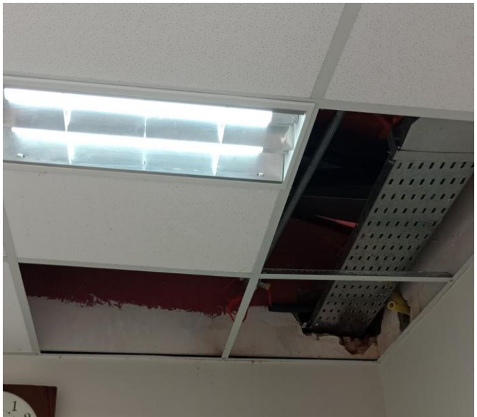
Placas de forro em fibra mineral danificadas ou retiradas, nas instalações da PTM de Coronel Fabriciano.
