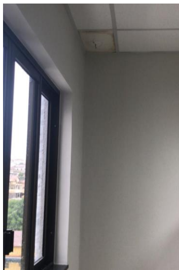
Placas de forro em fibra mineral danificadas, instalada na PTM de Varginha.
