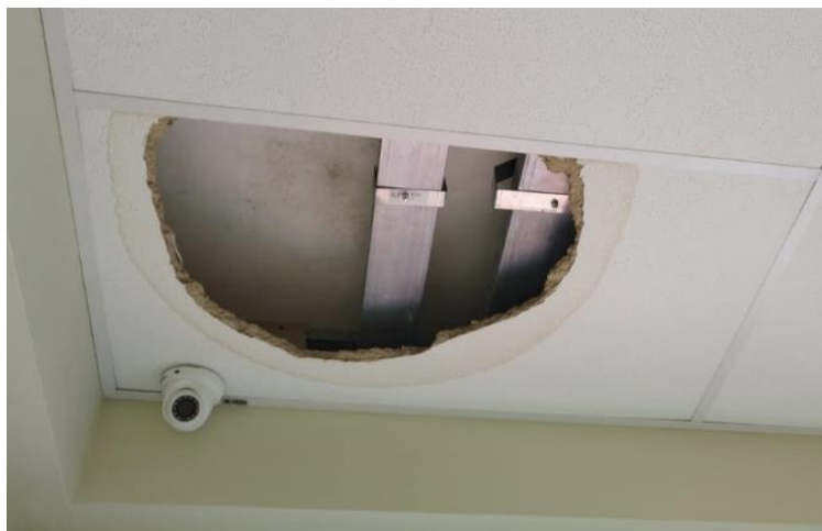
Placa de forro em fibra mineral danificada, instalada na PTM de Pouso Alegre.
