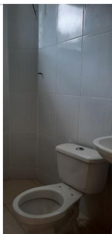
Banheiro 01 Sala 304 - Vista 02
