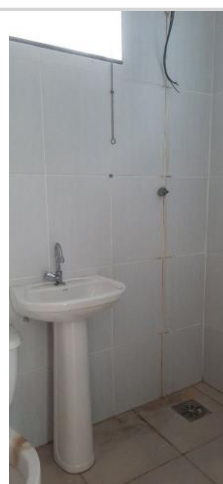
Banheiro 01 Sala 304 - Vista 01
