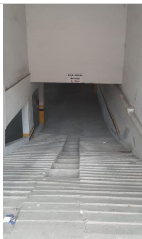
Rampa do estacionamento - Vista 01
