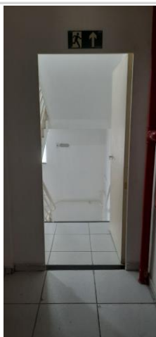
Rota de saída de fuga pela escada
