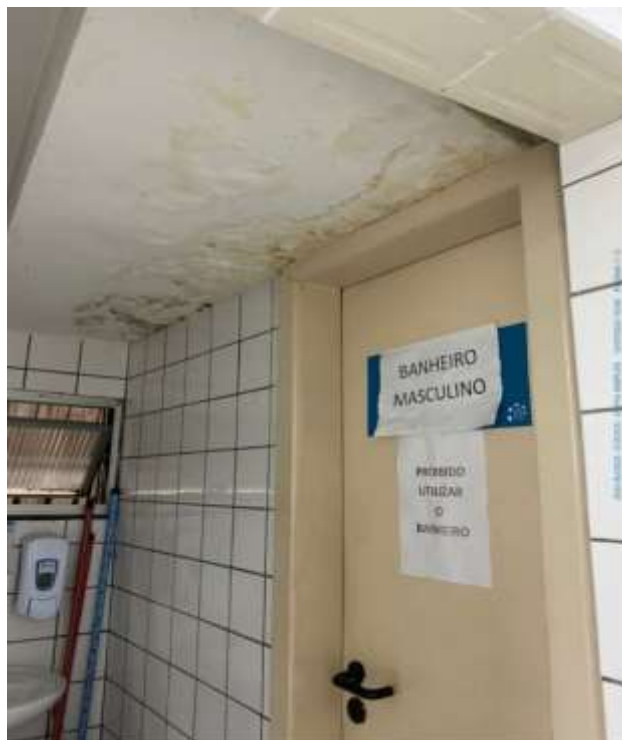
Figura 2 – Parede com infiltração
