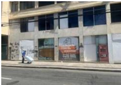
Foto 1: Imóvel vistoriado FRENTE.
