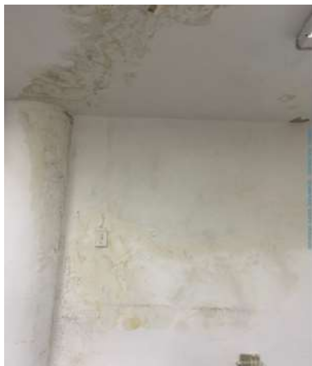
Figura 2 – Parede com infiltração
