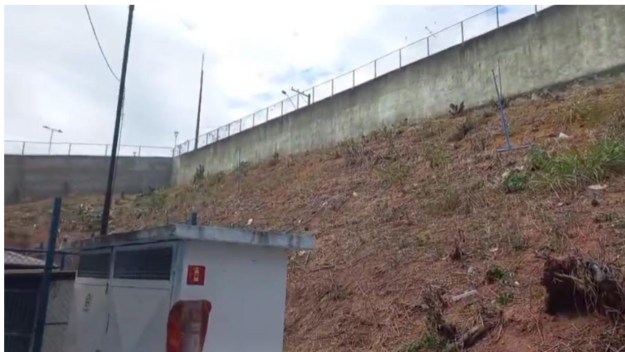
Foto 06 – Vista interna do muro pela face sul.
