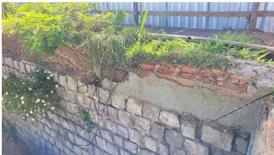
Foto 04 – Vista interna do Muro de Arrimo.
