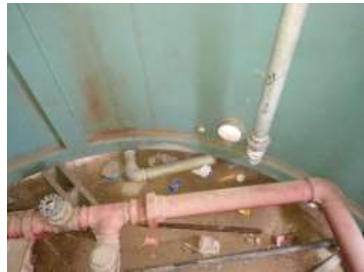
Foto nº 8 – Piso do barrilete em concreto armado.
