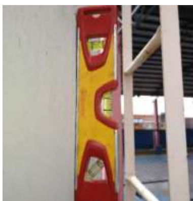
Foto nº 15 – Registro do nível do castelo d'água.
