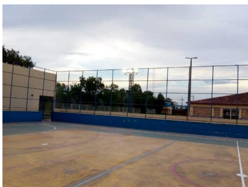
Foto nº 3 – EEEM Mário Gurgel: vista da quadra cuja cobertura foi demolida
