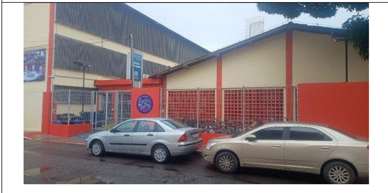
Foto 3 – Fachada e entrada principal da escola.
