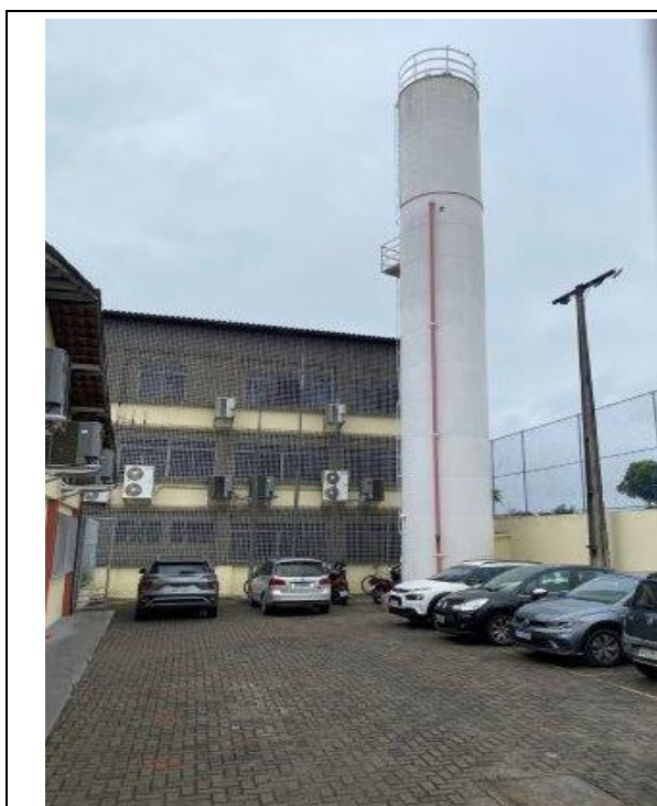
Foto 04 – Vista do estacionamento e castelo d'água existente.
