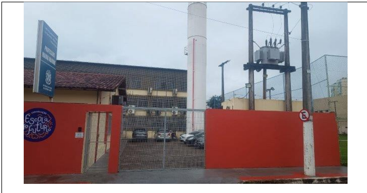
Foto 2 – Fachada e entrada do estacionamento da escola.
