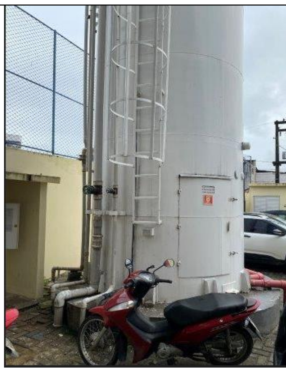
Foto 05 – Castelo d'água existente.
