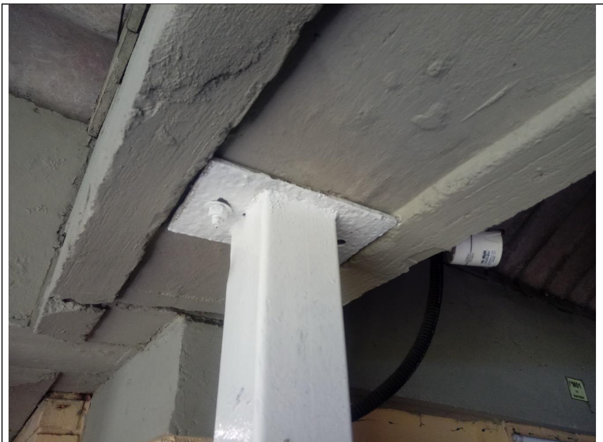
Foto nº 15 – Escoramento metálico realizado. Viga 04
