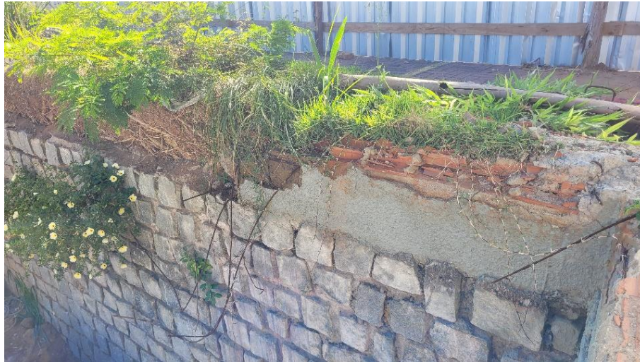
Foto 04 – Vista interna do Muro de Arrimo.
