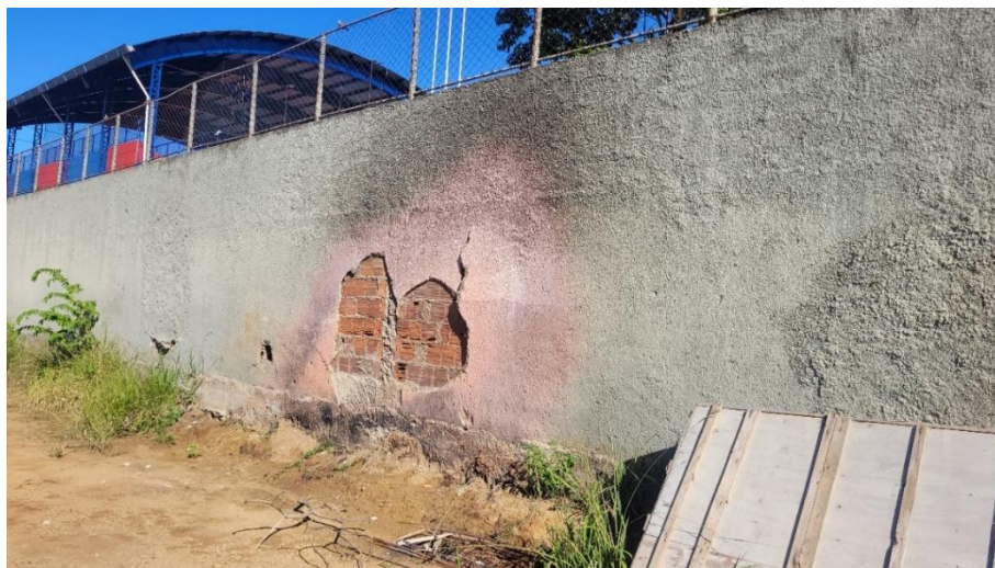
Foto 07 – Vista externa do muro de fundos, Face NORTE.
