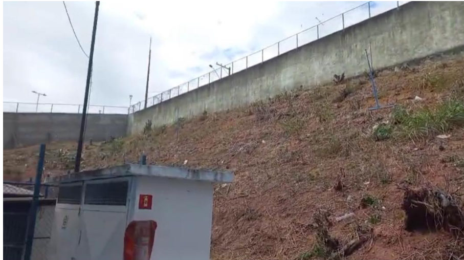
Foto 06 – Vista interna do muro pela face sul.
