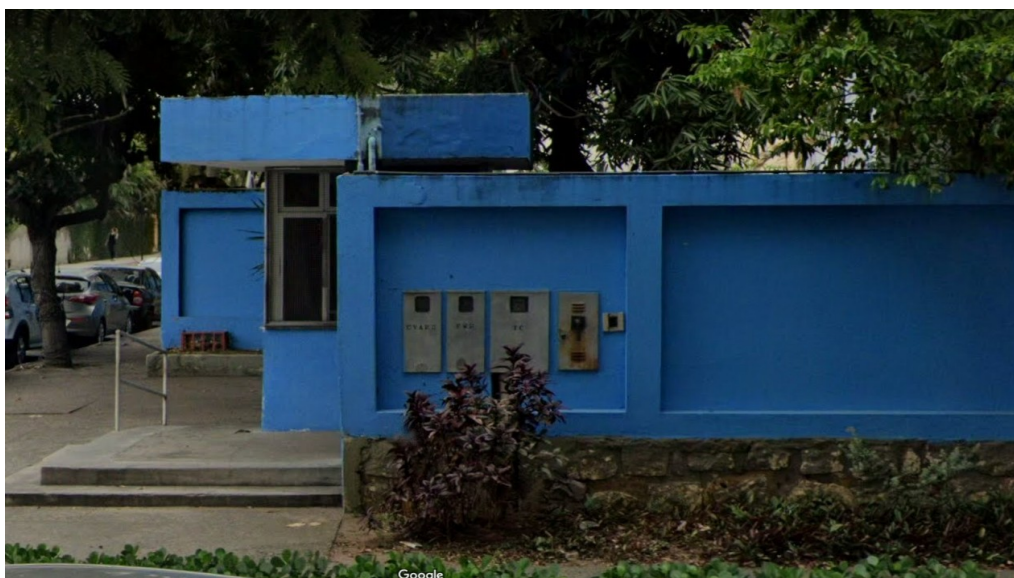
Figura 2 – Vista externa e do padrão de entrada de energia atual
