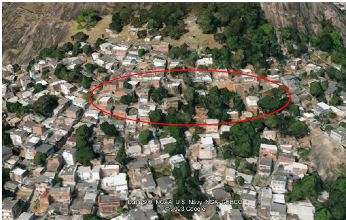
Figura 2 - Vista geral do talude objeto do Laudo nº 048/2023 Fonte Memorial descritivo do Projeto de Contenção
