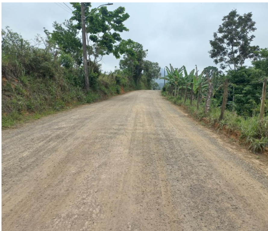
Imagem 09: Foto atualizada do local da obra.
