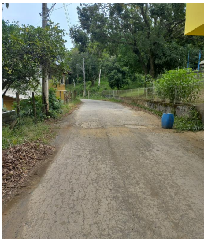
Imagem 05: Foto atualizada do local da obra.
