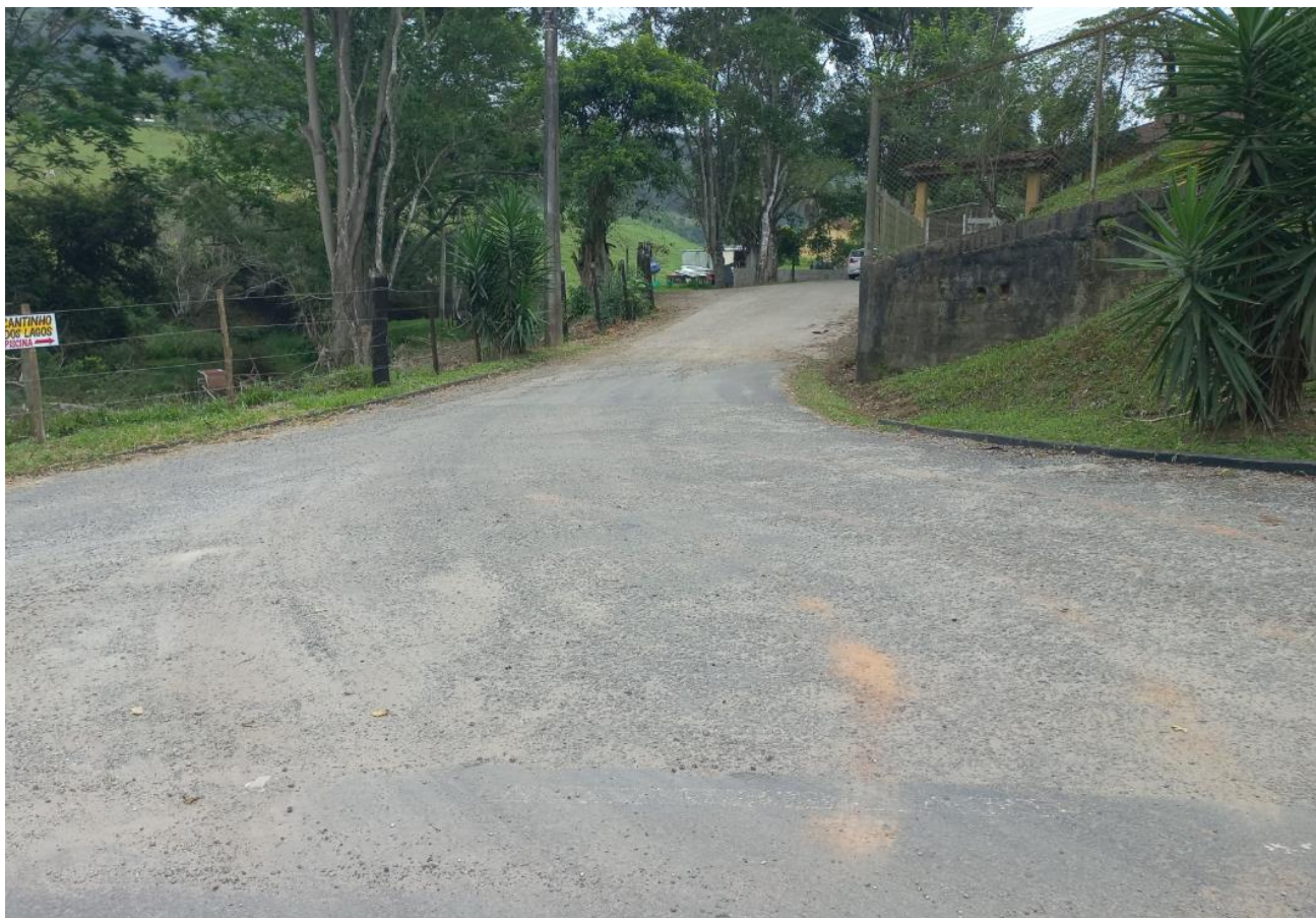
Imagem 04: Foto atualizada do local da obra.
