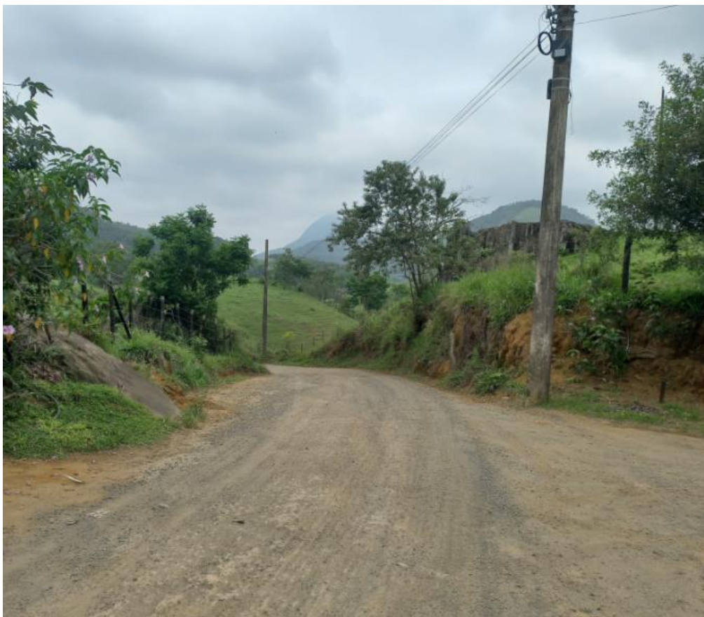
Imagem 08: Foto atualizada do local da obra.
