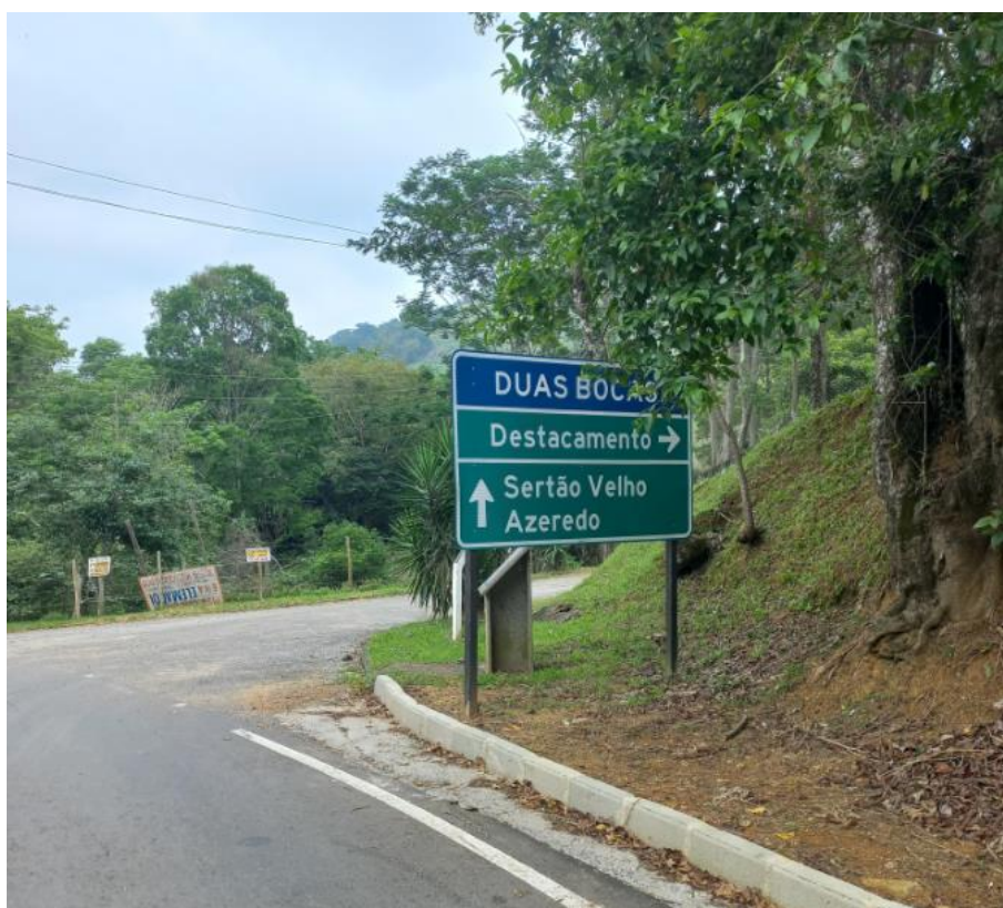
Imagem 03: Foto atualizada do local da obra.
