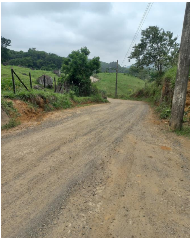
Imagem 06: Foto atualizada do local da obra.
