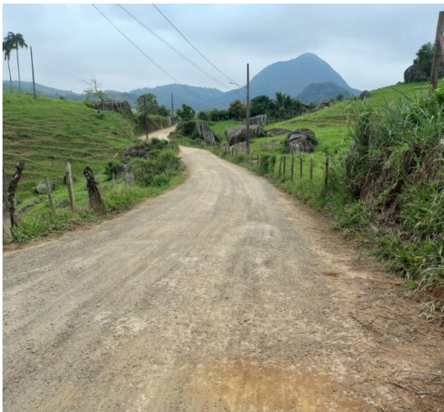
Imagem 07: Foto atualizada do local da obra.
