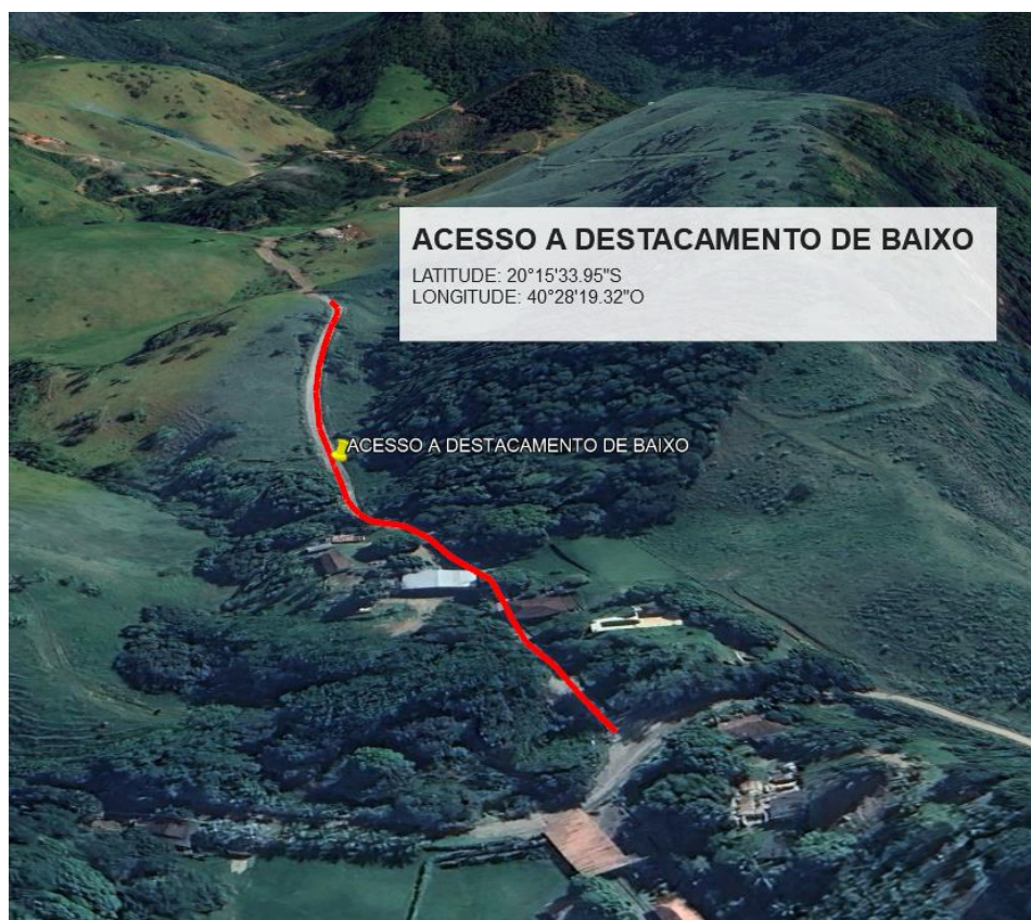
Imagem 02: Vista 3D do local da obra.
