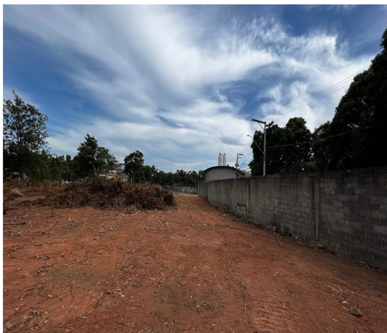
Imagem 02: Foto atualizada do local da obra
