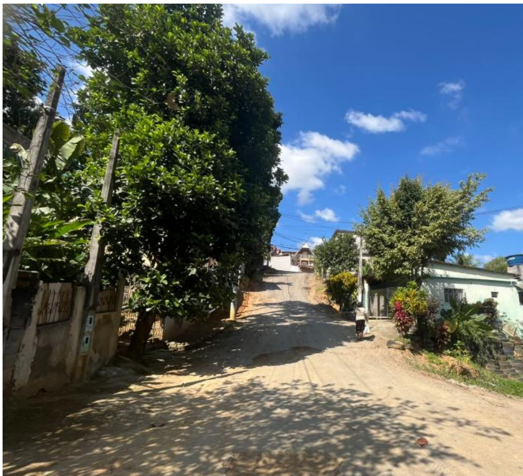
Imagem 09: Foto atualizada do local da obra – Rua Santa Mônica.
