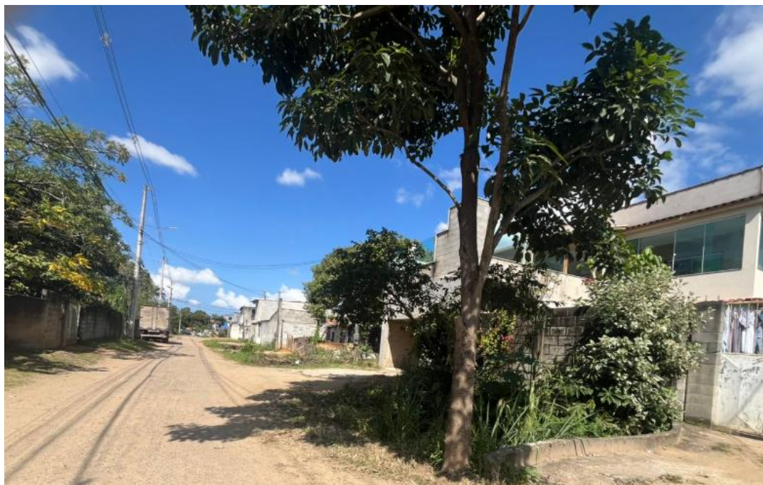
Imagem 08: Foto atualizada do local da obra – Rua Ipanema.
