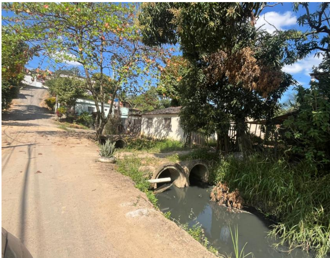
Imagem 10: Foto atualizada do local da obra – Rua Santa Mônica.
