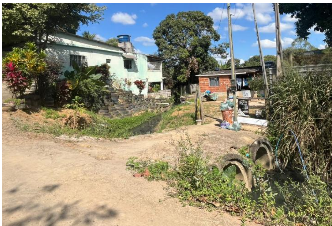
Imagem 15: Foto atualizada do local da obra – Local de passagem da galeria de drenagem.
