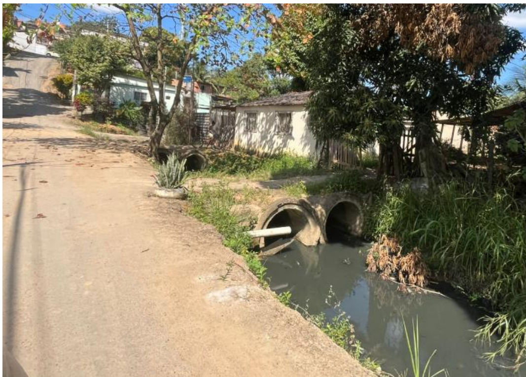
Imagem 16: Foto atualizada do local da obra – Local de passagem da galeria de drenagem.
