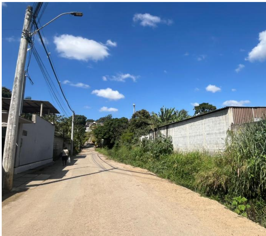
Imagem 12: Foto atualizada do local da obra – Rua Santa Mônica.
