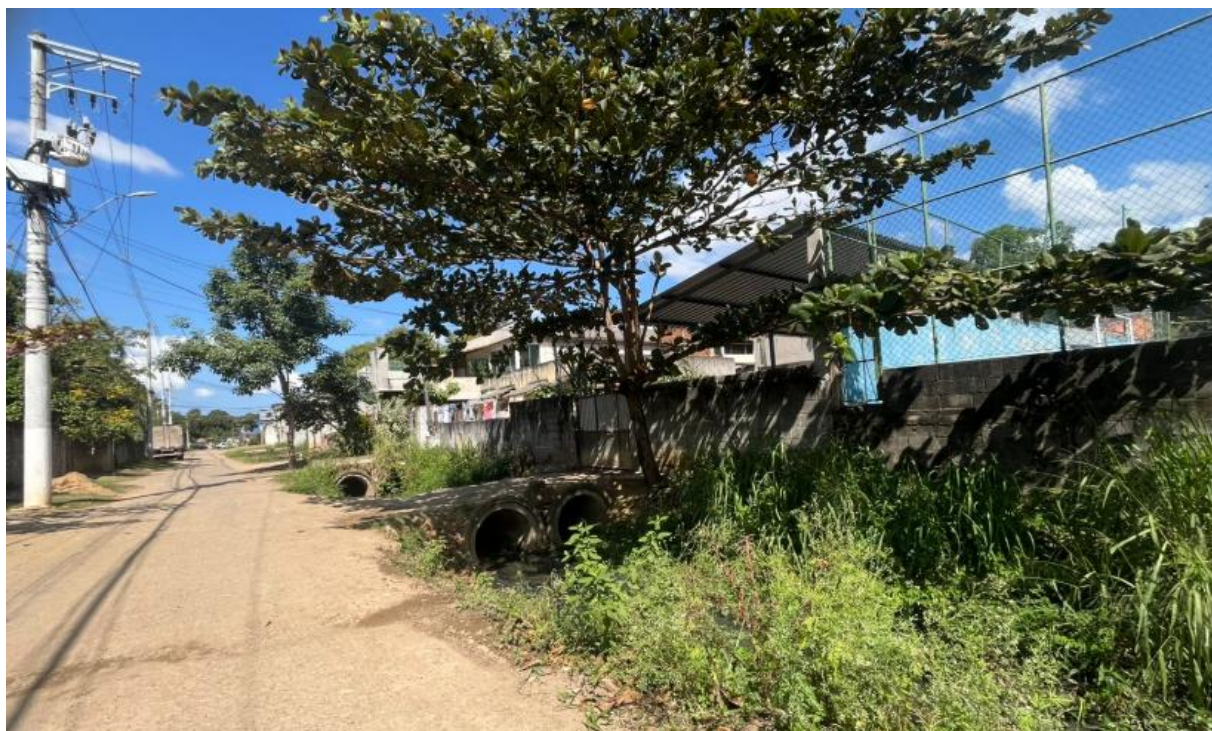
Imagem 07: Foto atualizada do local da obra – Rua Ipanema.
