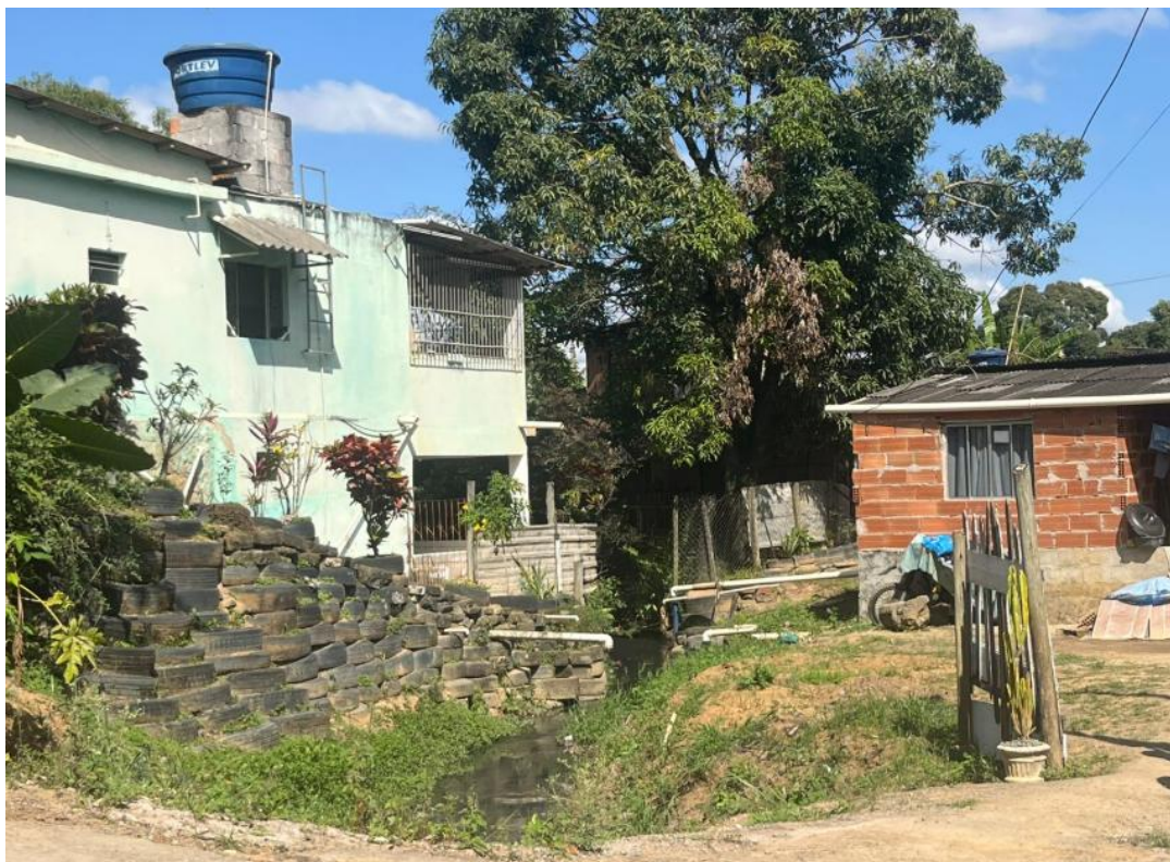
Imagem 14: Foto atualizada do local da obra – Local de passagem da galeria de drenagem.
