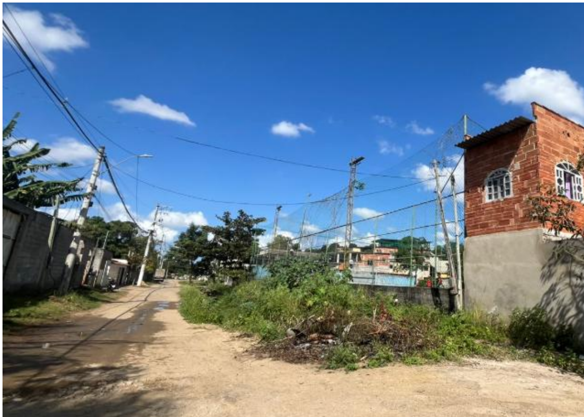
Imagem 06: Foto atualizada do local da obra – Rua Ipanema.
